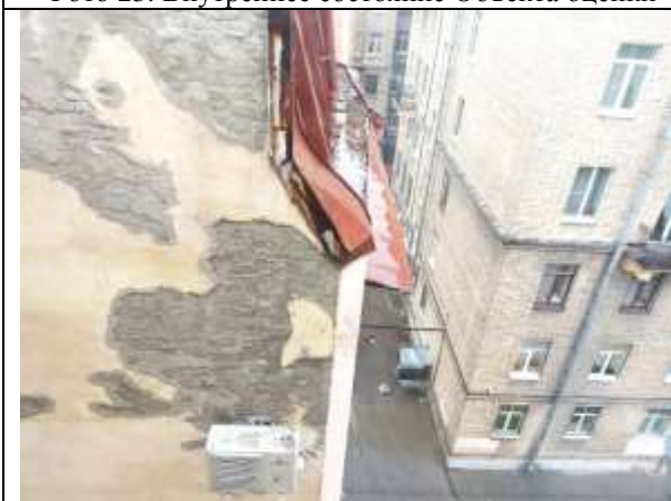
Фото 25. Внутреннее состояние Объекта оценки (вид из окна)
