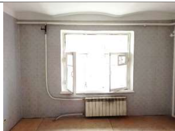
Фото 20. Внутреннее состояние Объекта оценки
