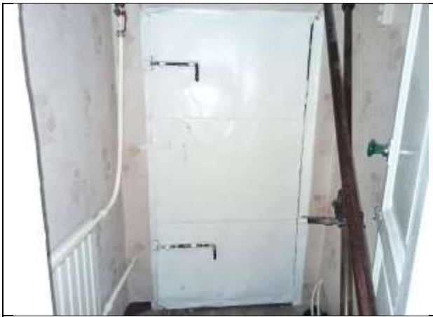
Фото 27. Внутреннее состояние Объекта оценки (выход на крышу из ч.п. 7)
