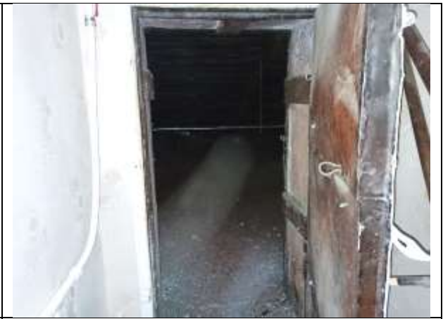
Фото 28. Внутреннее состояние Объекта оценки (выход на крышу)
