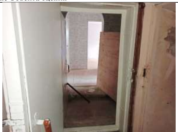
Фото 16. Внутреннее состояние Объекта оценки
