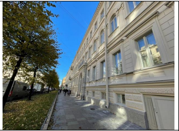
Фото 30. Вид здания Объекта оценки
