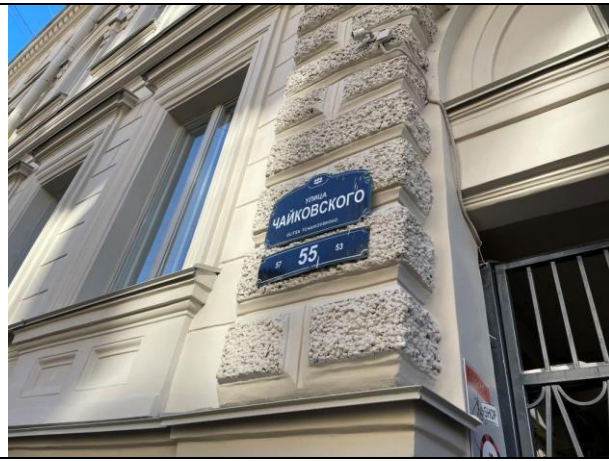
Фото 29. Адрес Объекта оценки
