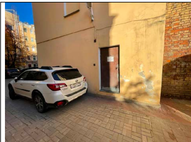
Фото 19. Вид здания расположения Объекта оценки
