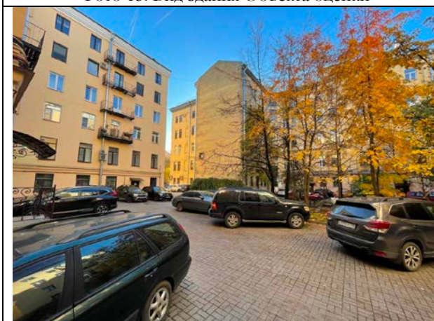
Фото 17. Внутри дворовая территория Объекта оценки
