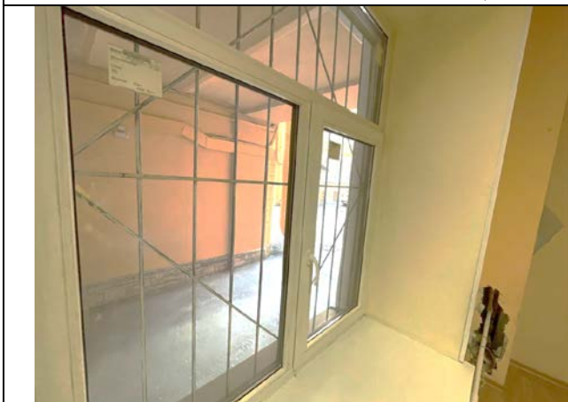
Фото 25. Типичное состояние Объекта оценки
