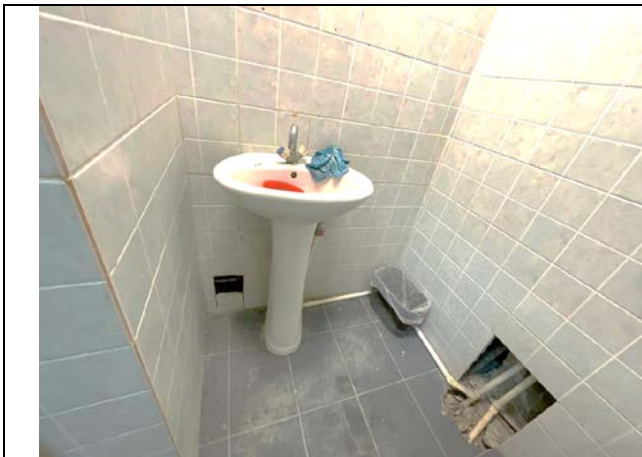
Фото 27. Типичное состояние Объекта оценки
