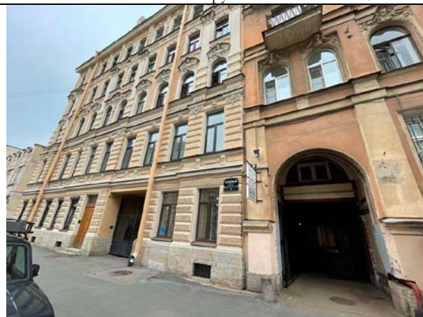
Фото 14. Вид здания расположения Объекта оценки с Саперного переулка
