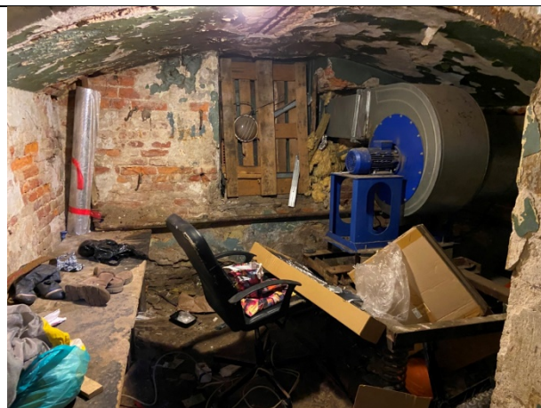
Фото № 14 – Внутреннее состояние помещения
