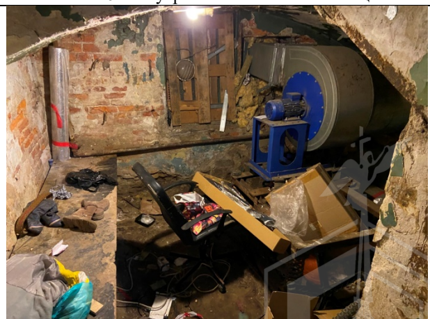
Фото № 12 – Внутреннее состояние помещения
