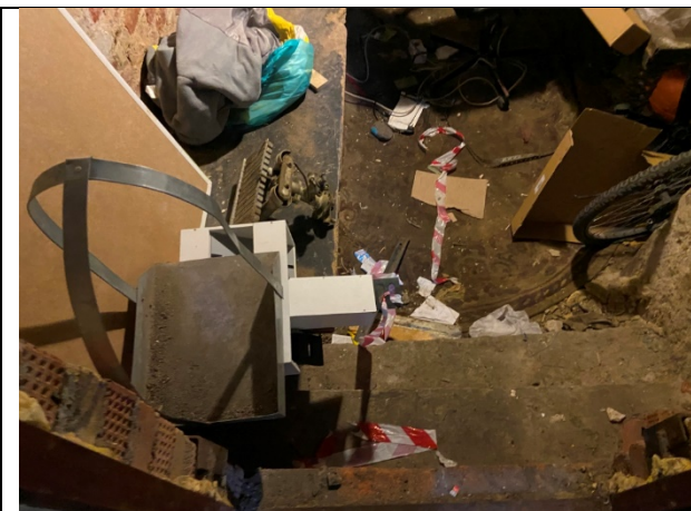
Фото № 13 – Внутреннее состояние помещения
