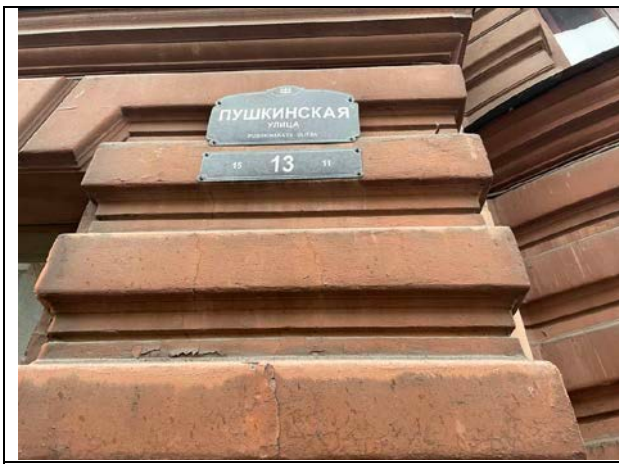
Фото 29. Адрес Объекта оценки
