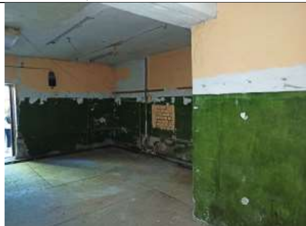
Фото 8. Внутреннее состояние Объекта оценки
