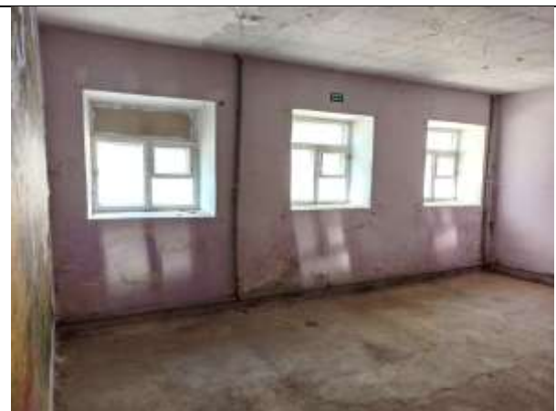
Фото 14. Внутреннее состояние Объекта оценки
