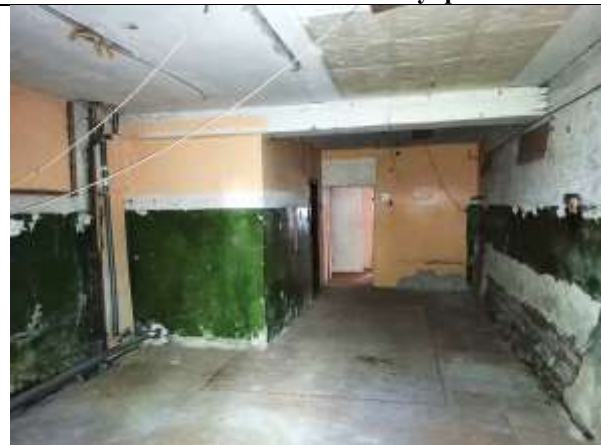
Фото 7. Внутреннее состояние Объекта оценки
