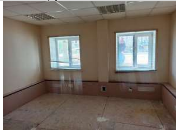
Фото 11. Внутреннее состояние Объекта оценки
