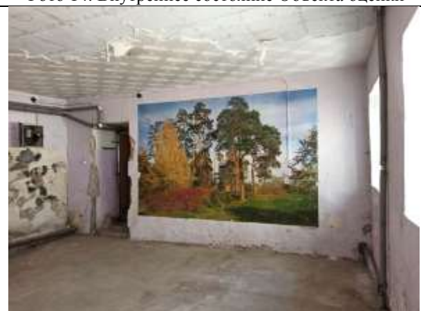
Фото 16. Внутреннее состояние Объекта оценки
