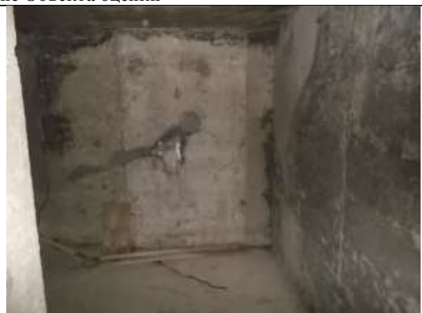
Фото 8. Внутреннее состояние Объекта оценки
