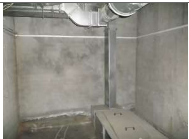
Фото 18. Внутреннее состояние Объекта оценки
