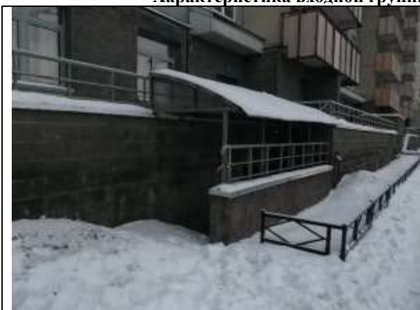
Фото 5 Отдельный вход с улицы
