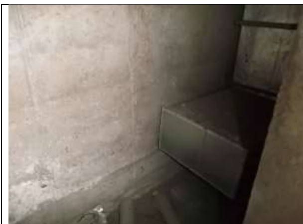
Фото 17. Внутреннее состояние Объекта оценки
