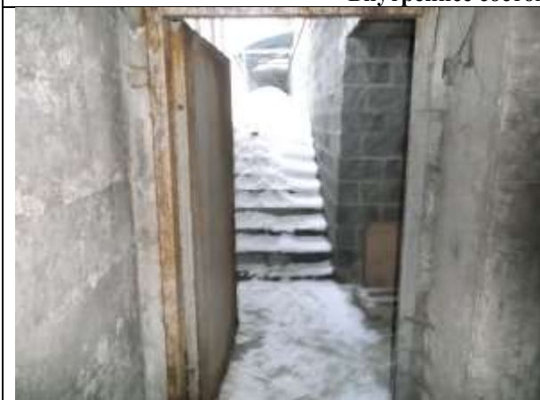
Фото 7. Внутреннее состояние Объекта оценки
