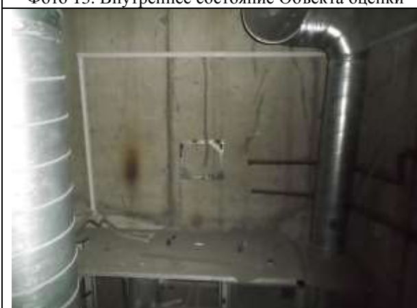
Фото 15. Внутреннее состояние Объекта оценки
