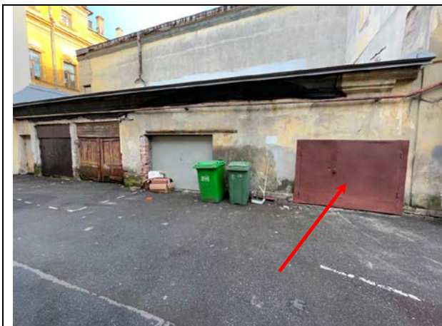
Фото 21. Вид здания Объекта оценки (входная группа Объекта оценки) (ч.п.1 пом.10-Н)
