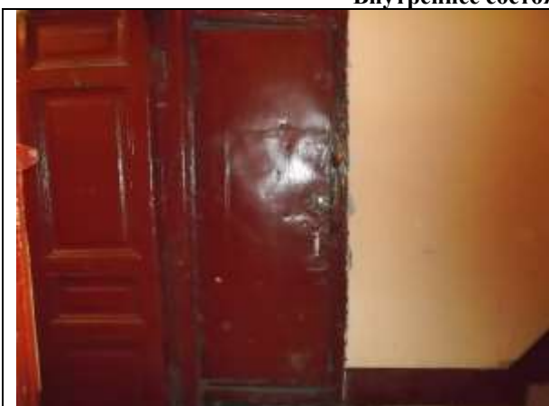
Фото 11. Внутреннее состояние Объекта оценки
