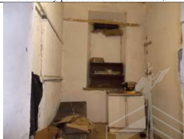
Фото 20. Внутреннее состояние Объекта оценки
