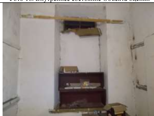
Фото 18. Внутреннее состояние Объекта оценки
