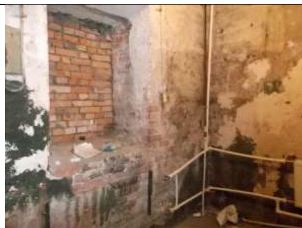
Фото 14. Внутреннее состояние Объекта оценки
