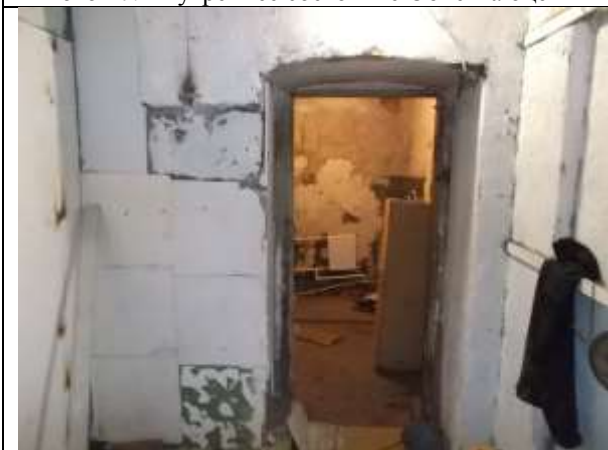
Фото 19. Внутреннее состояние Объекта оценки
