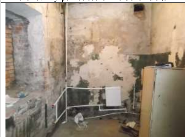
Фото 15. Внутреннее состояние Объекта оценки
