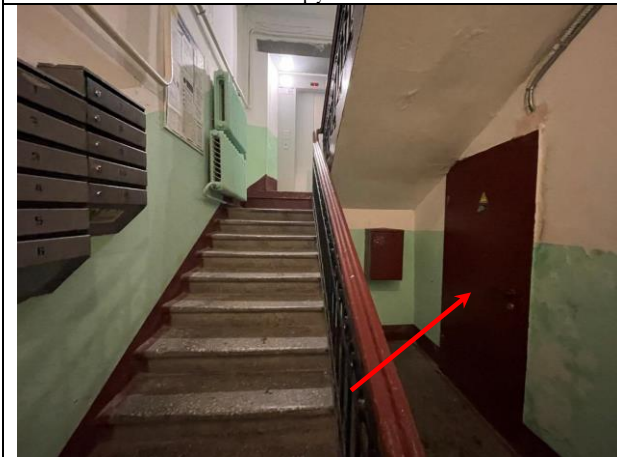
Фото 23. Лестничный проем Объекта оценки
