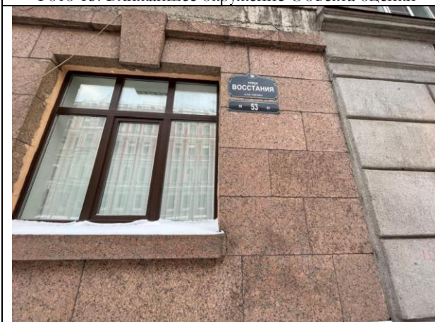
Фото 17. Адрес объекта оценки
