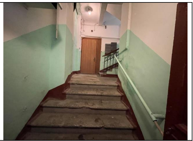
Фото 22. Лестничный проем Объекта оценки
