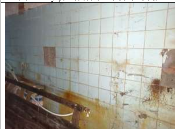
Фото 13. Внутреннее состояние Объекта оценки
