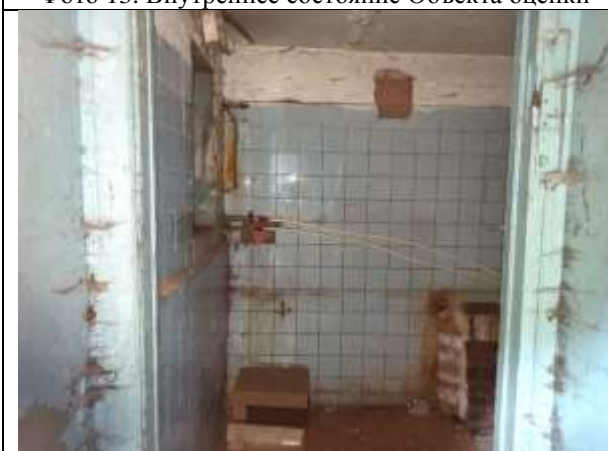
Фото 15. Внутреннее состояние Объекта оценки
