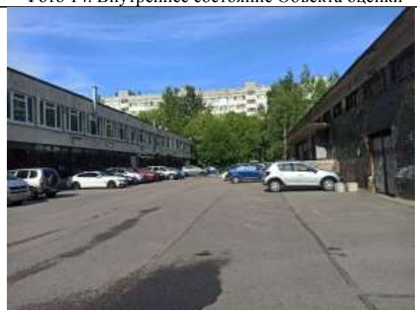
Фото 16. Внутреннее состояние Объекта оценки
