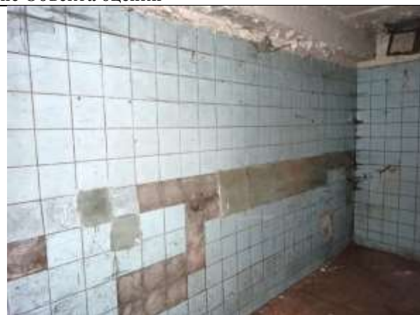
Фото 8. Внутреннее состояние Объекта оценки
