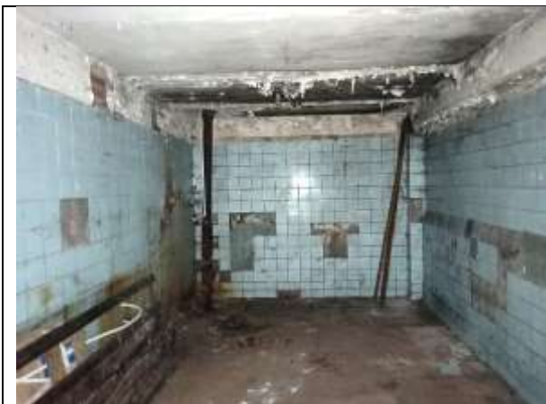
Фото 11. Внутреннее состояние Объекта оценки
