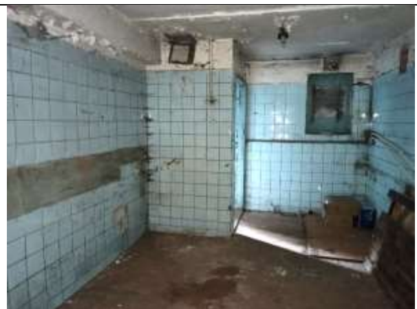
Фото 12. Внутреннее состояние Объекта оценки
