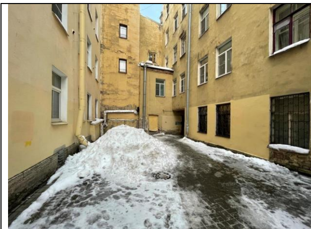
Фото 17. Внутри дворовая территория Объекта оценки
