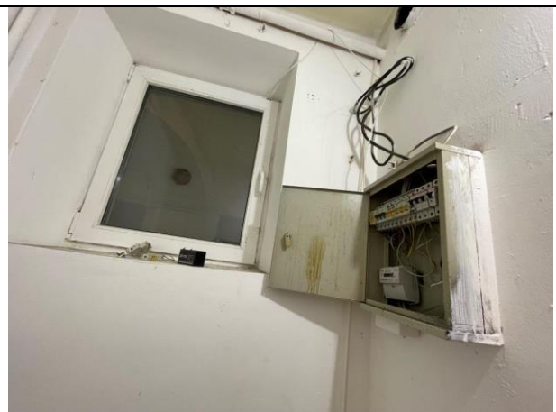
Фото 26. Типичное состояние Объекта оценки
