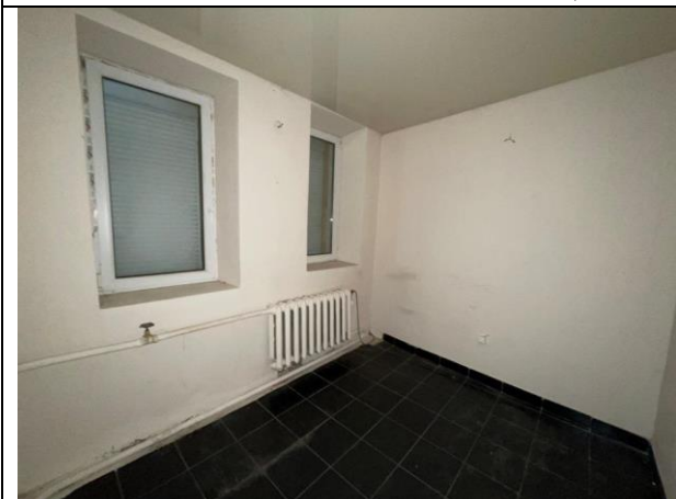
Фото 23. Типичное состояние Объекта оценки
