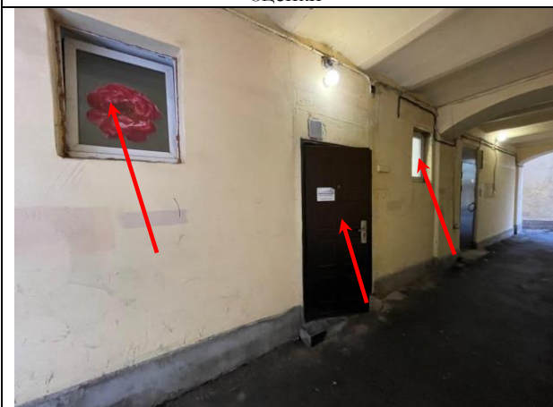
Фото 19. Входная и оконная группа Объекта оценки
