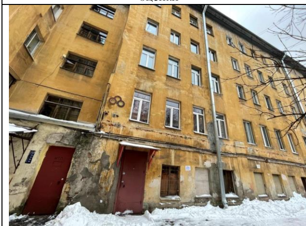
Фото 19. Вид здания расположения Объекта оценки
