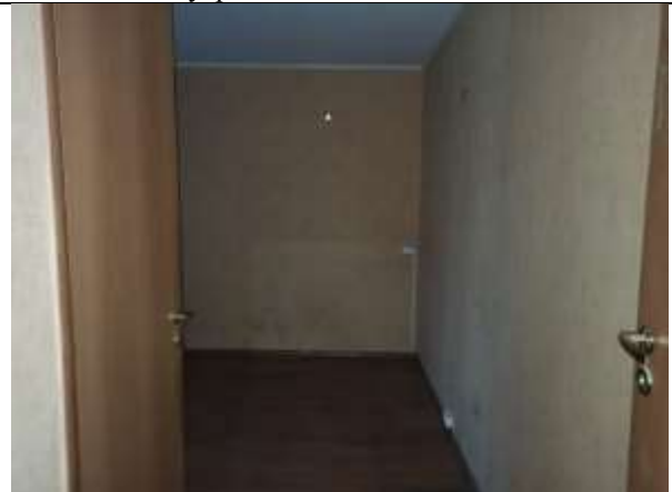
Фото 14. Внутреннее состояние Объекта оценки
