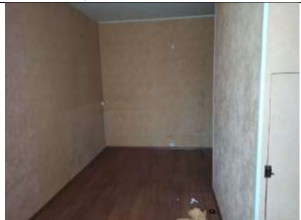
Фото 10. Внутреннее состояние Объекта оценки
