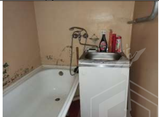
Фото 16. Внутреннее состояние Объекта оценки
