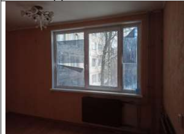
Фото 13. Внутреннее состояние Объекта оценки
