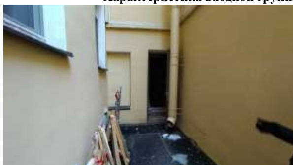
Фото 7. Доступ Объекта оценки. Отдельный вход со двора, окно (заложено)
