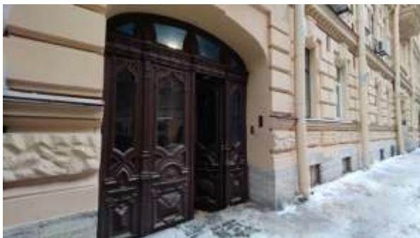
Фото 9. Доступ Объекта оценки. Общий вход с улицы
