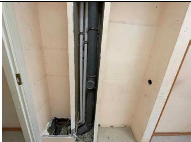
Фото 32. Типичное состояние Объекта оценки
