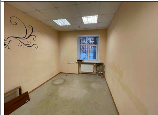
Фото 29. Типичное состояние Объекта оценки
