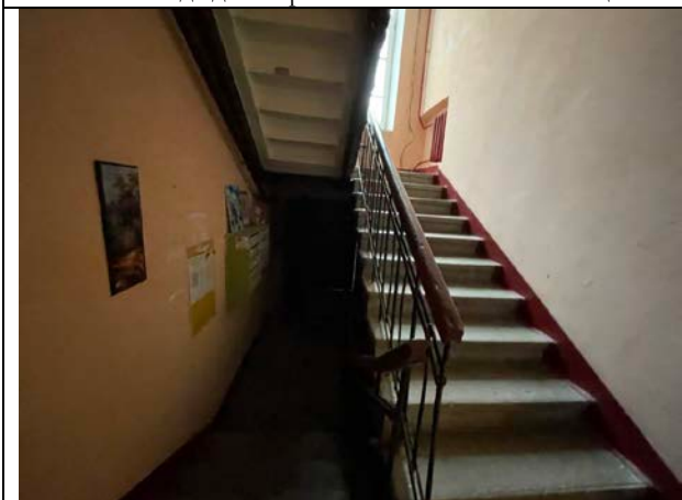
Фото 21. Лестничный проём Объекта оценки
