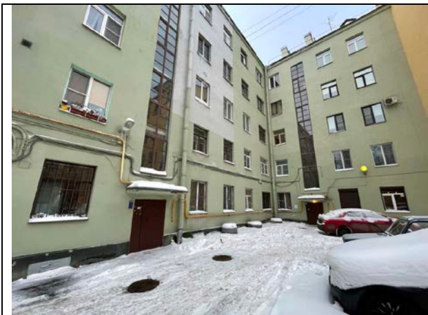
Фото 19. Вид здания расположения Объекта оценки
