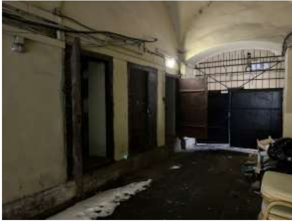
Фото 7. Доступ Объекта оценки. Отдельный вход со двора
