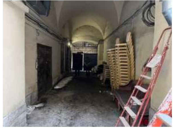
Фото 8. Доступ Объекта оценки. Отдельный вход со двора
