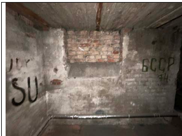
Фото 21. Типичное состояние Объекта оценки
