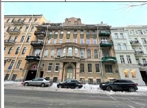
Фото 7. Вид здания расположения Объекта оценки
