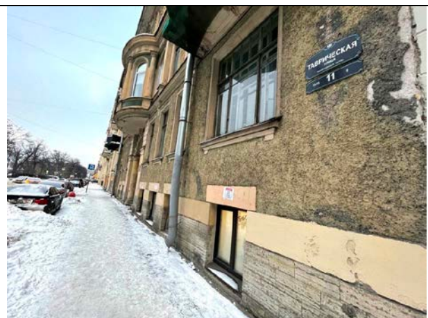
Фото 6. Вид здания расположения Объекта оценки
