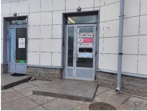
Фото 7. Общий вход с улицы
