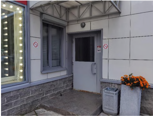
Фото 9. Общий вход с улицы
