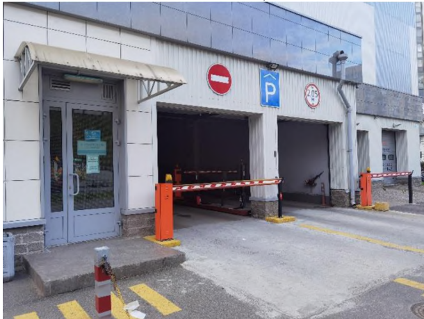
Фото 5. Въезд в паркинг
