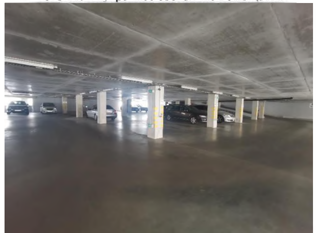
Фото 12. Внутреннее состояние помещения
