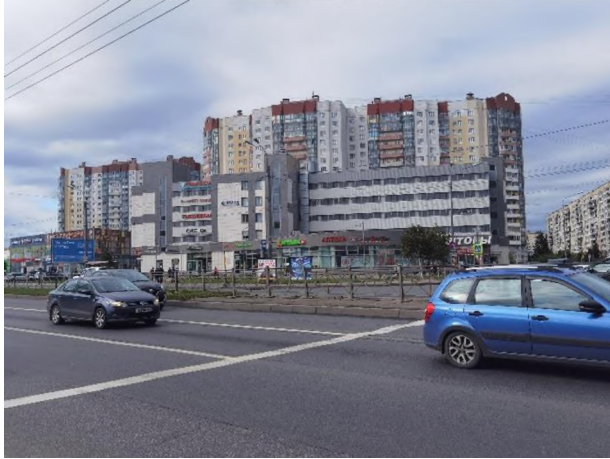
Фото 1. Общий вид здания, в котором расположен Объект оценки, с проспекта Косыгина
