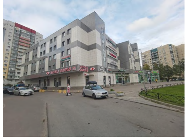
Фото 2. Общий вид здания, в котором расположен Объект оценки
