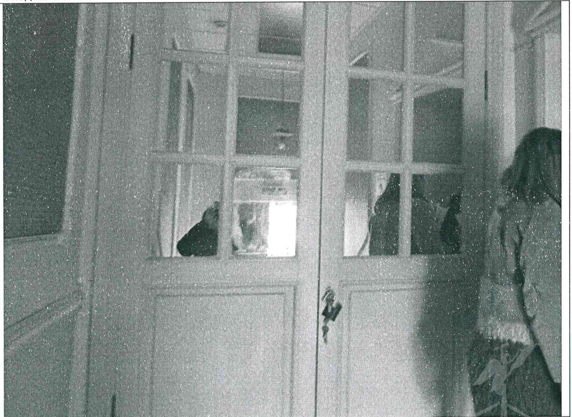
Описание: Вид внутри ч.п. 6 Объекта оборудован дверной проем
