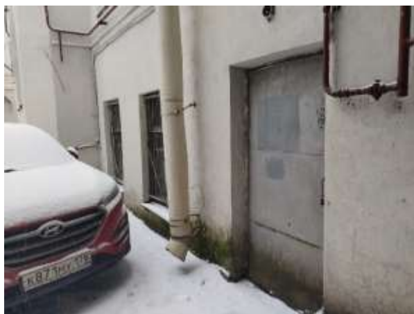
Фото 7. 1 отдельный вход со двора и окна Объекта оценки
