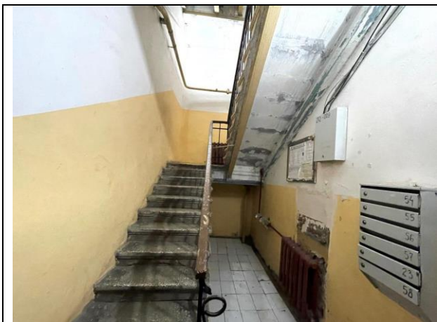
Фото 47. Лестница Объекта оценки
