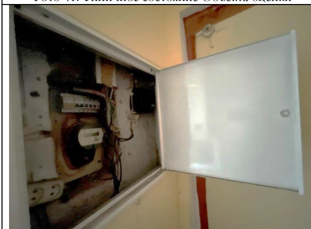
Фото 43. Типичное состояние Объекта оценки
