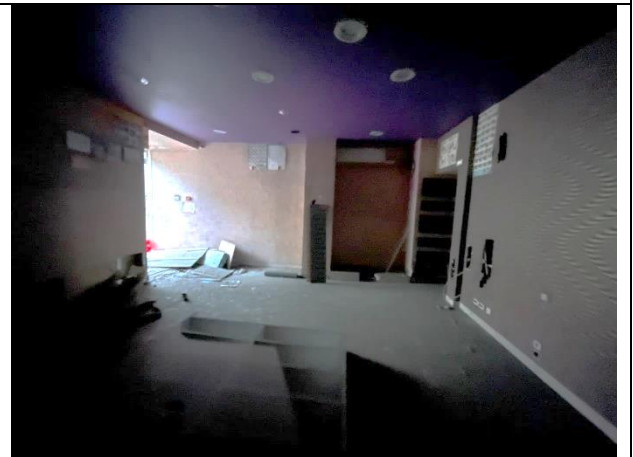
Фото 42. Типичное состояние Объекта оценки
