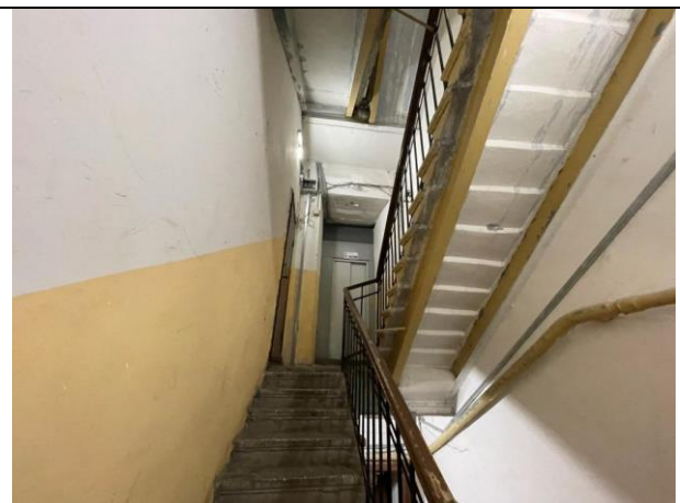
Фото 48. Лестница Объекта оценки
