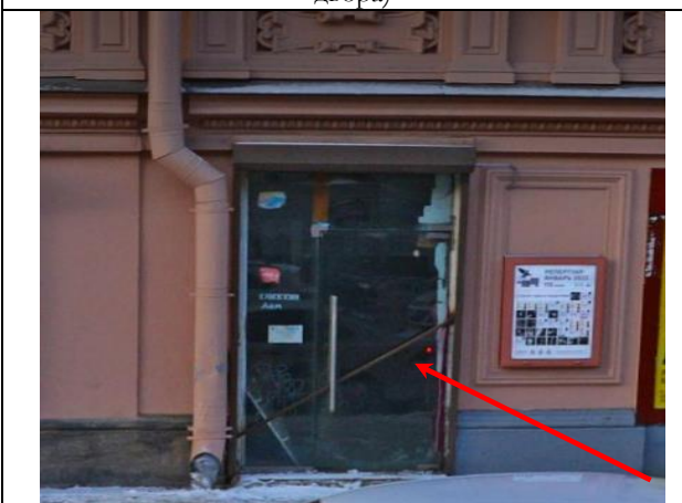
Фото 37. Входная группа Объекта оценки (отдельный вход с улицы)
