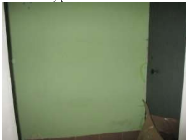
Фото 16. Внутреннее состояние Объекта оценки
