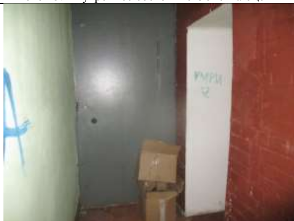
Фото 17. Внутреннее состояние Объекта оценки
