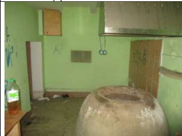
Фото 23. Внутреннее состояние Объекта оценки
