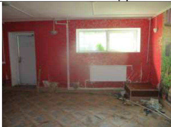
Фото 13. Внутреннее состояние Объекта оценки
