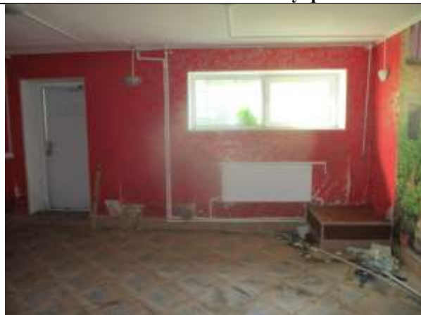
Фото 13. Внутреннее состояние Объекта оценки
