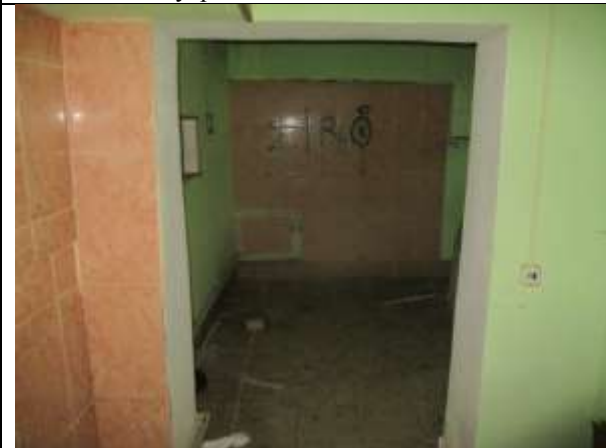
Фото 21. Внутреннее состояние Объекта оценки
