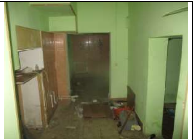
Фото 20. Внутреннее состояние Объекта оценки
