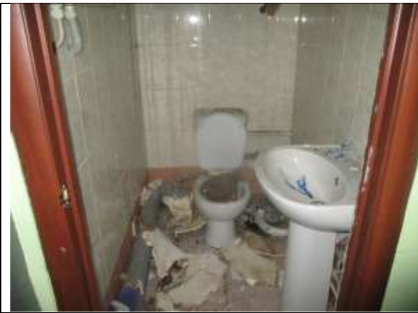
Фото 19. Внутреннее состояние Объекта оценки
