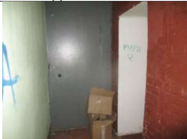
Фото 17. Внутреннее состояние Объекта оценки
