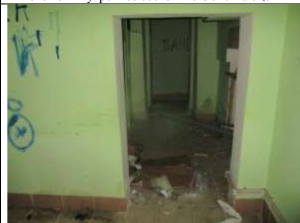
Фото 25. Внутреннее состояние Объекта оценки
