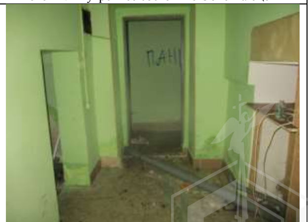
Фото 26. Внутреннее состояние Объекта оценки
