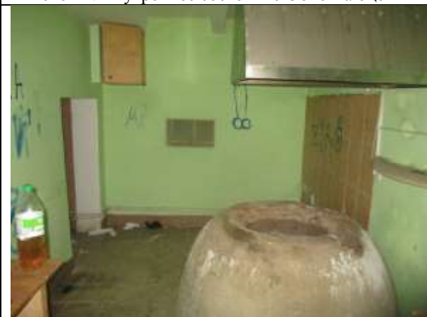
Фото 23. Внутреннее состояние Объекта оценки
