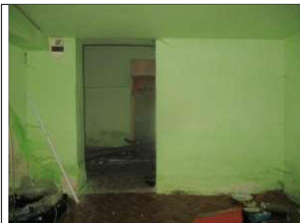
Фото 27. Внутреннее состояние Объекта оценки
