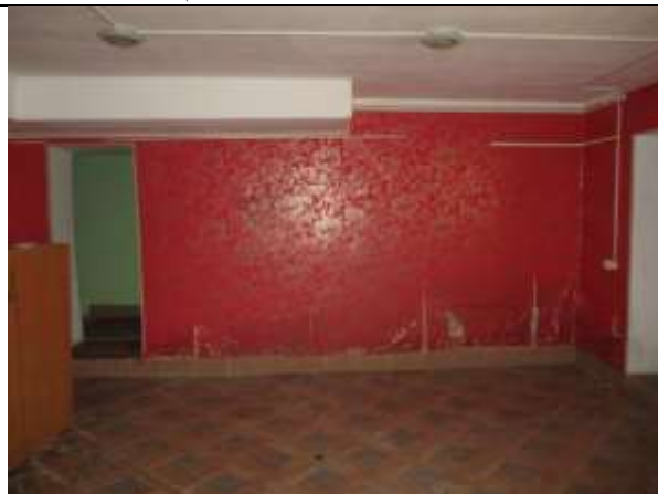
Фото 14. Внутреннее состояние Объекта оценки
