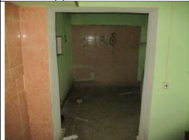
Фото 21. Внутреннее состояние Объекта оценки
