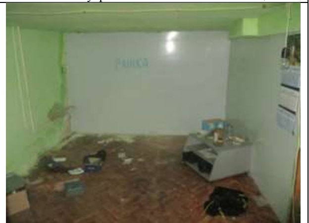
Фото 24. Внутреннее состояние Объекта оценки
