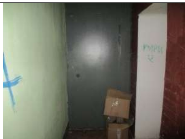
Фото 28. Внутреннее состояние Объекта оценки
