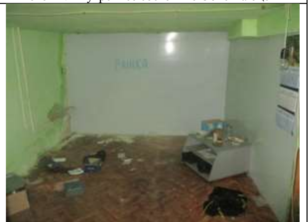
Фото 24. Внутреннее состояние Объекта оценки
