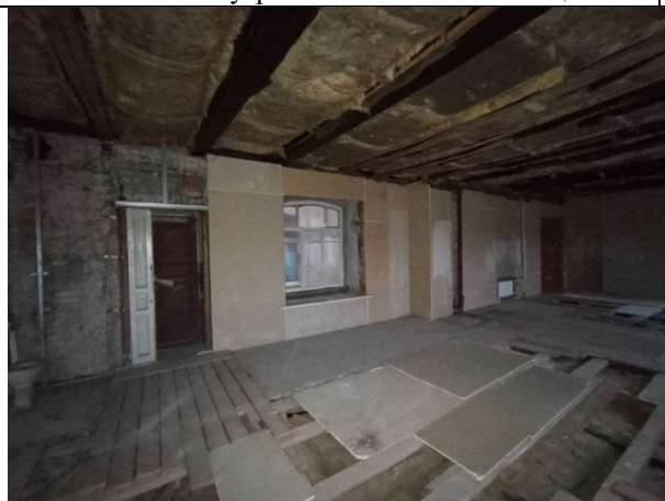
Фото № 15 – Внутреннее состояние помещения
