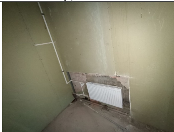
Фото № 16 – Внутреннее состояние помещения
