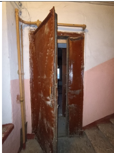
Фото № 6 – Вход в помещение
