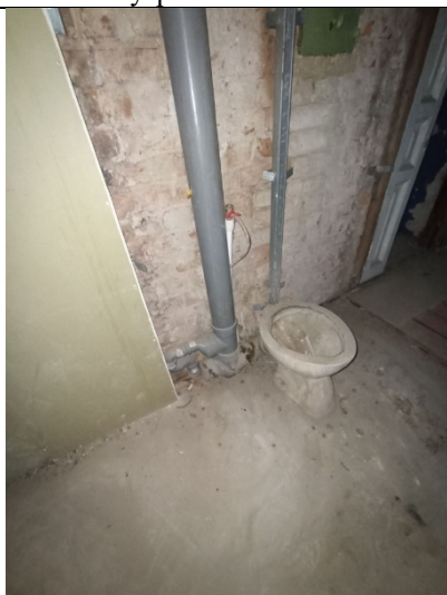
Фото № 13 – Внутреннее состояние помещения
