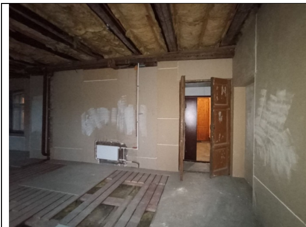
Фото № 11 – Внутреннее состояние помещения
