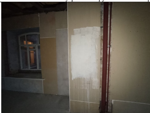
Фото № 9 – Внутреннее состояние помещения
