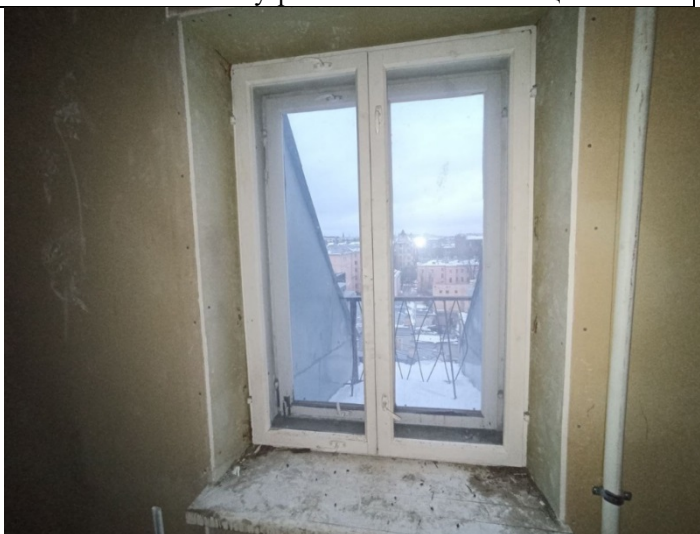
Фото № 14 – Внутреннее состояние помещения
