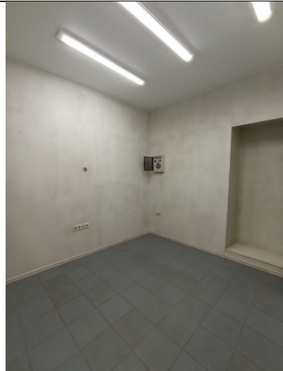
Фото № 10 – Внутреннее состояние помещения
