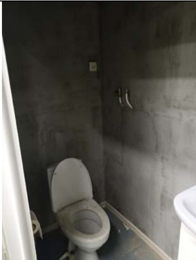
Фото № 15 – Внутреннее состояние помещения
