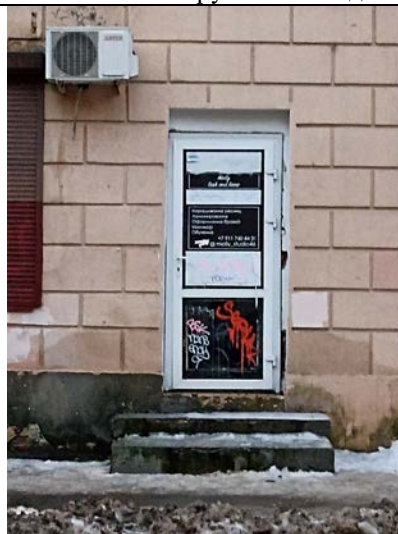
Фото № 4 – Вход в помещение с улицы
