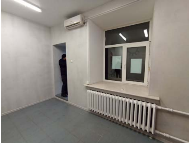
Фото № 7 – Внутреннее состояние помещения
