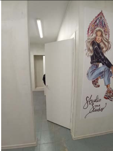
Фото № 21 – Внутреннее состояние помещения
