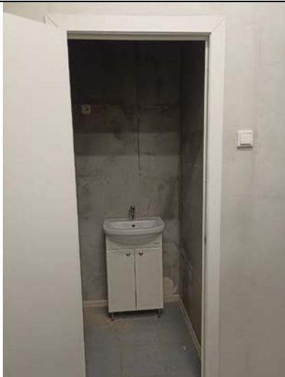
Фото № 13 – Внутреннее состояние помещения
