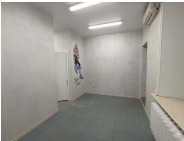
Фото № 17 – Внутреннее состояние помещения
