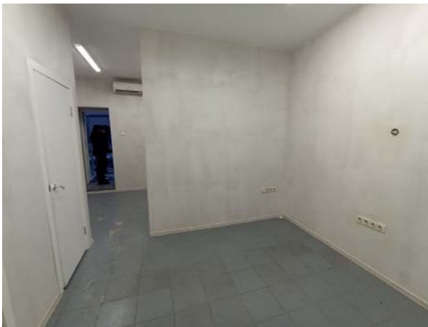
Фото № 9 – Внутреннее состояние помещения
