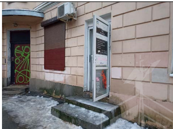
Фото № 6 – Вход в помещение с улицы
