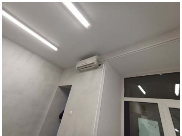
Фото № 20 – Внутреннее состояние помещения
