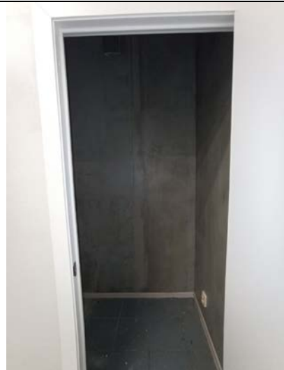
Фото № 16 – Внутреннее состояние помещения
