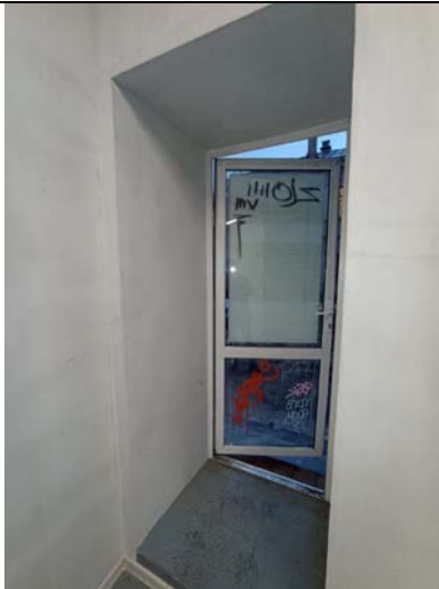
Фото № 19 – Внутреннее состояние помещения
