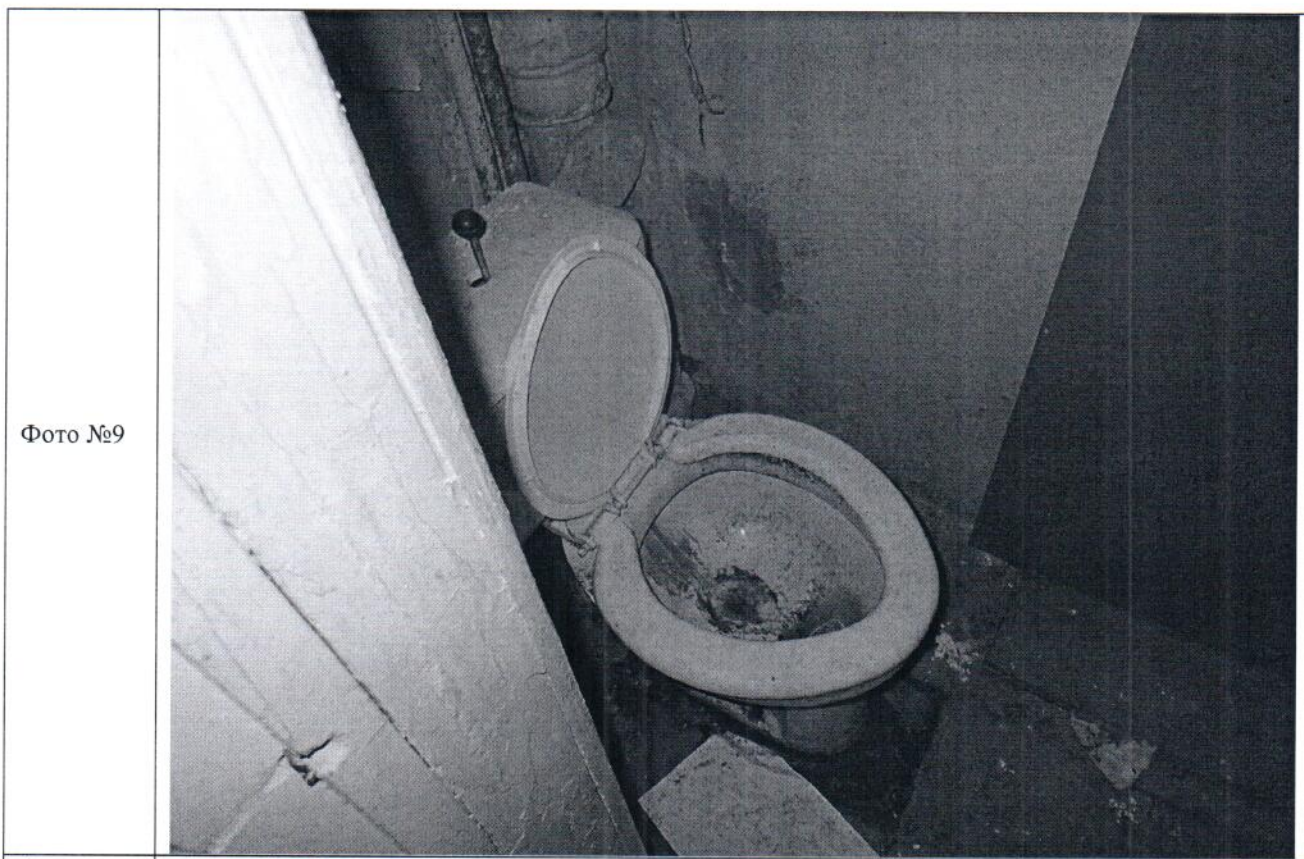
Описание вид ч.п. 5 Объекта
