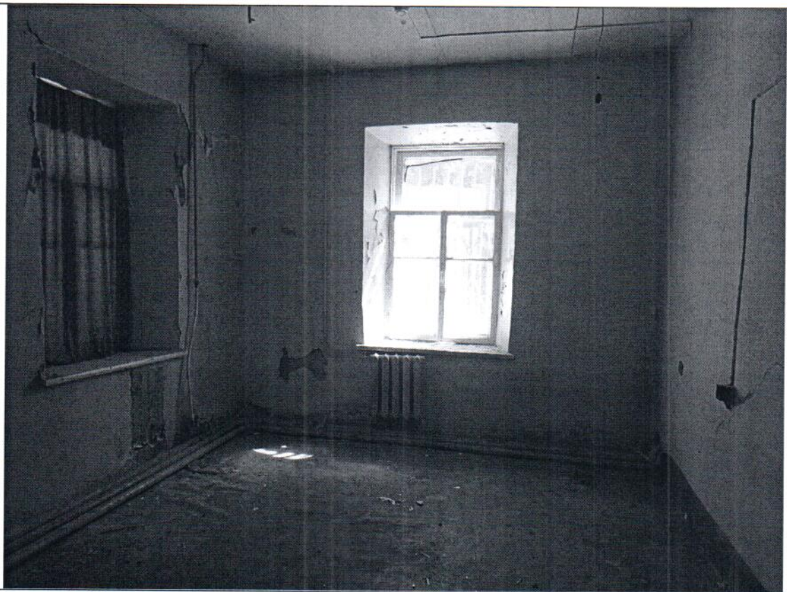
Описание вид ч.п. 7 Объекта
