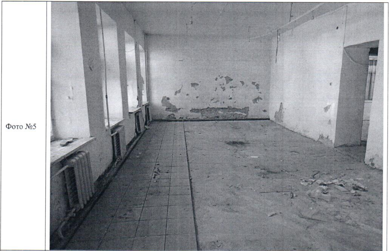
Описание: вид ч.п. 6 Объекта
