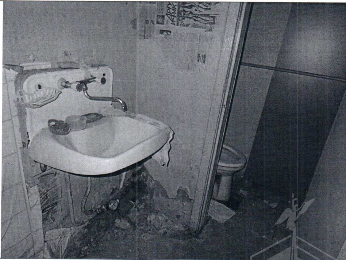
Описание вид ч.п. 4 Объекта
