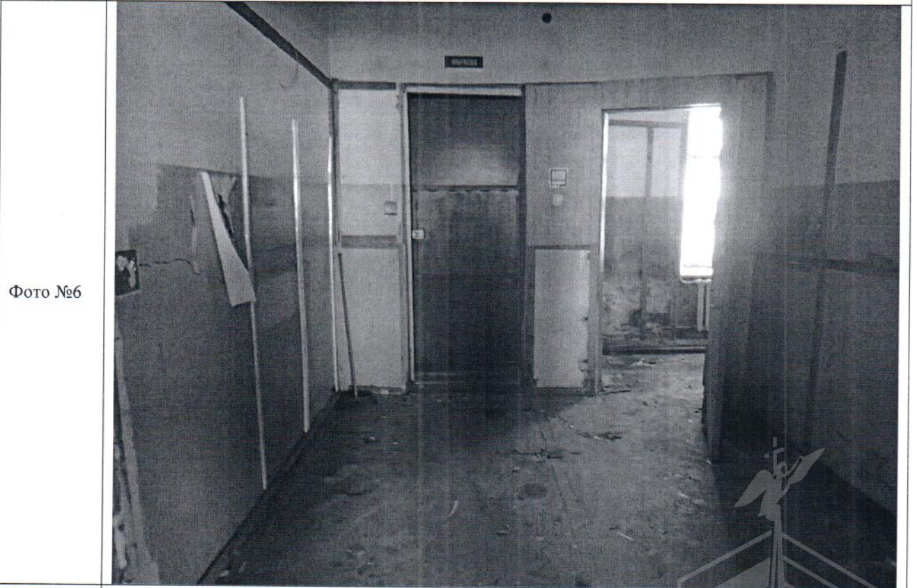
Описание: вид ч.п. 2 Объекта; вход на Объект
