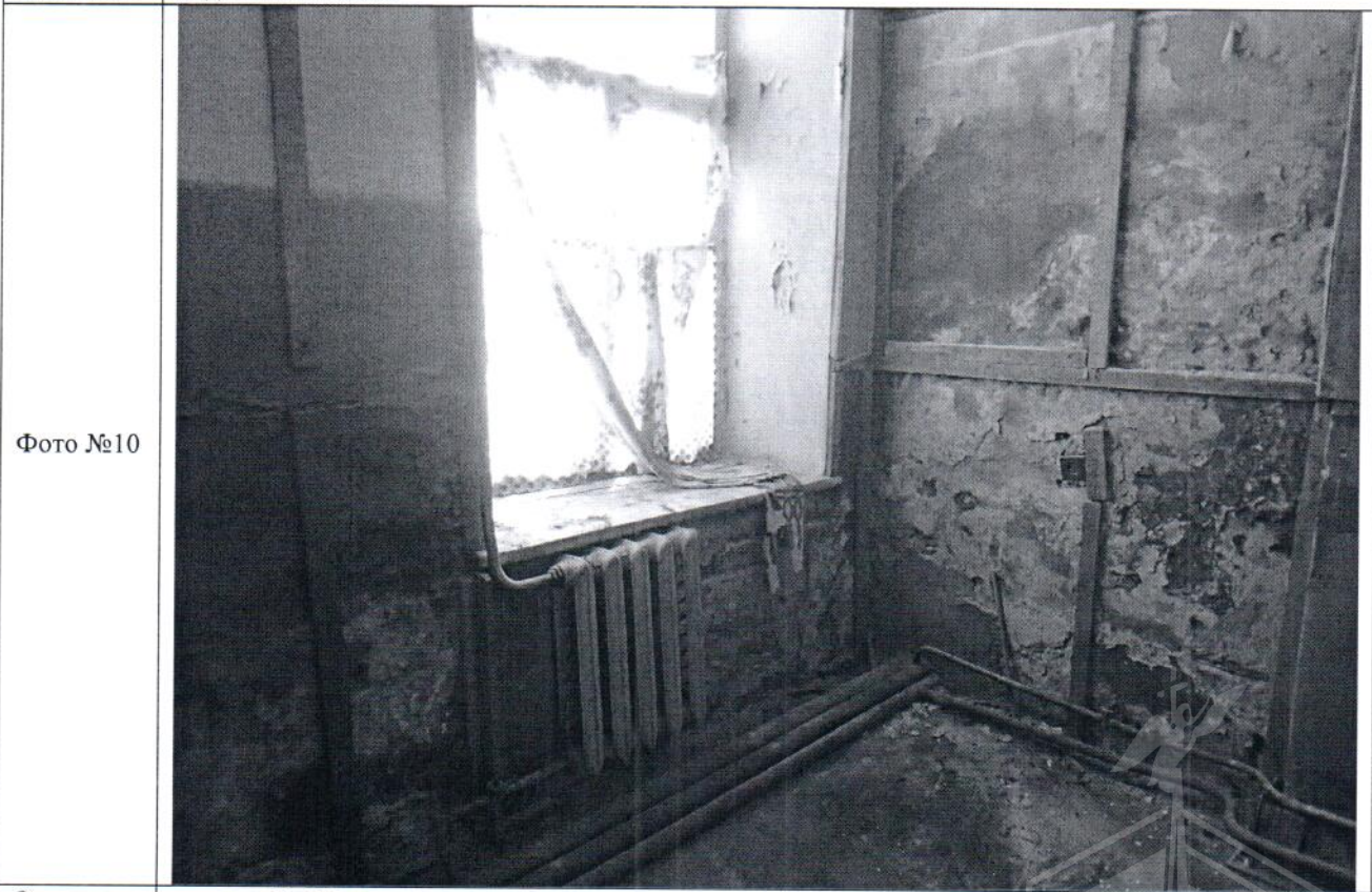
Описание вид ч.п. 7 Объекта
