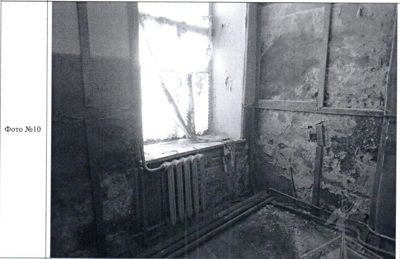
Описание вид ч.п. 7 Объекта
