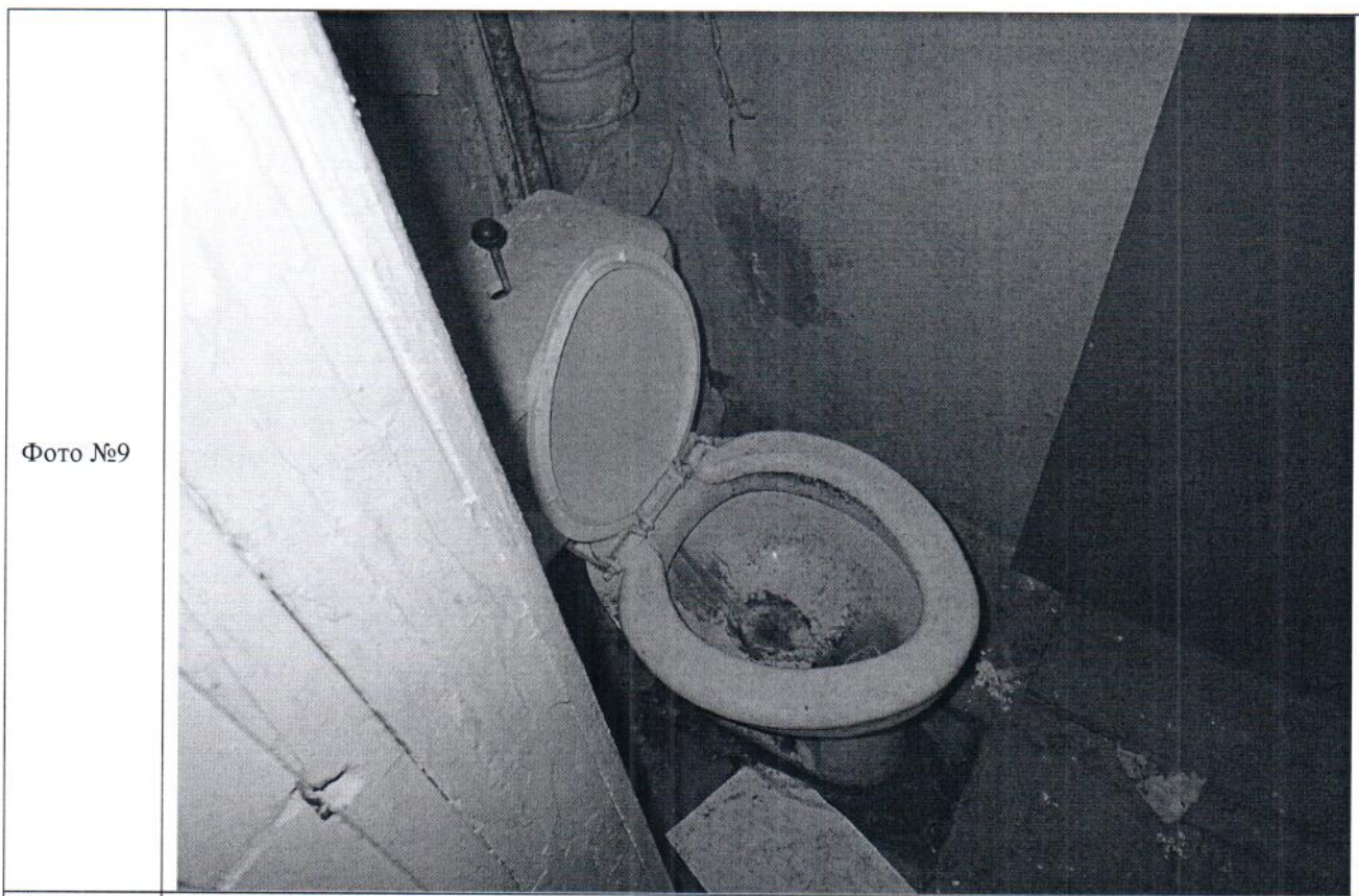
Описание вид ч.п. 5 Объекта
