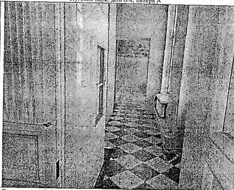
Описание: Вид внутри Объекта (в пом. 1-Н, 3-Н оборудована лифтовая шахта)
