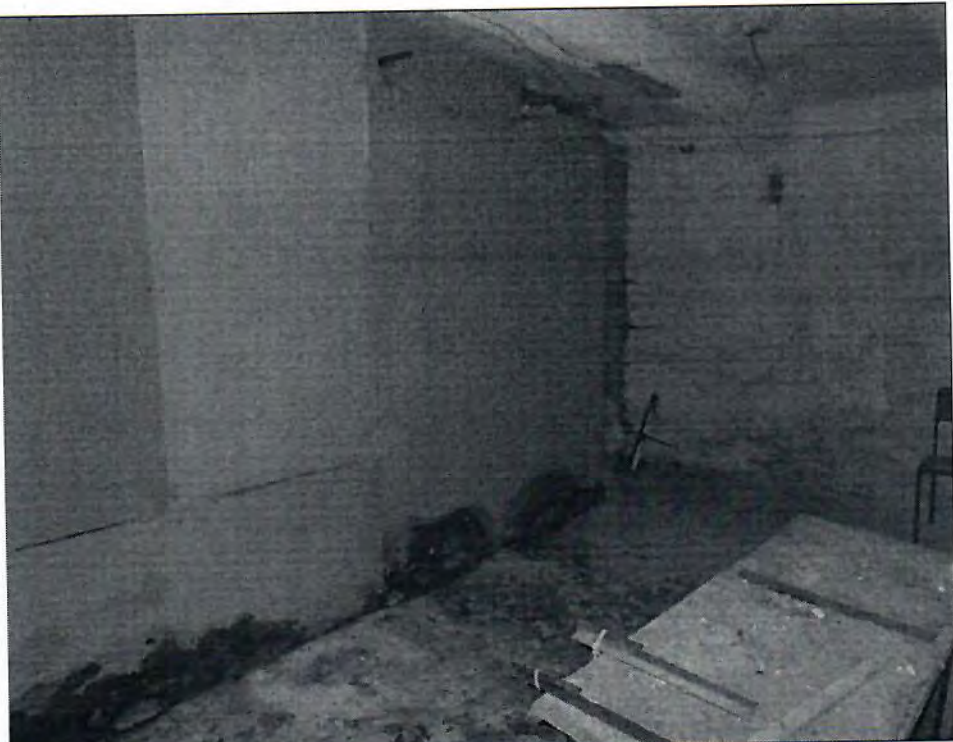
Описание: Вид внутри Объекта; ч.п. 5 Объекта разделена на три части.
