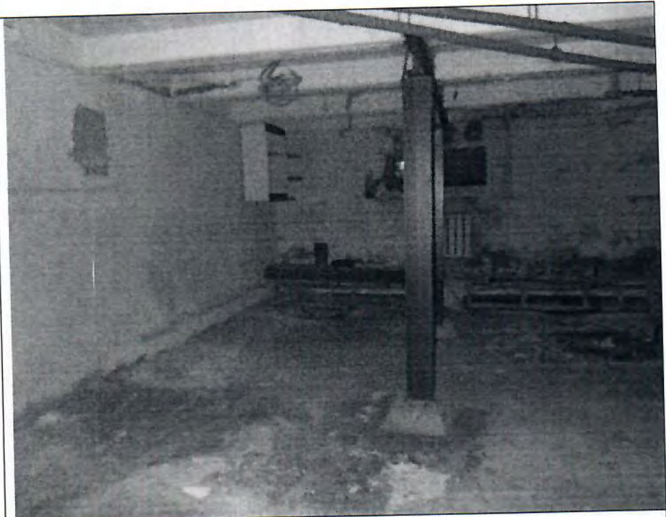
Описание: Вид внутри Объекта
