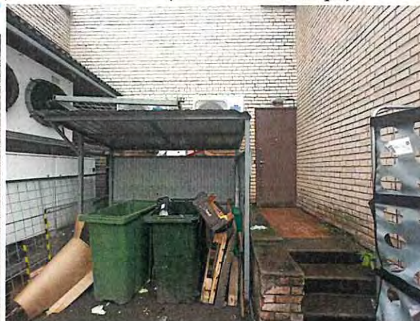
Фото № 40 (ч.п.2 пом.3-Н)
