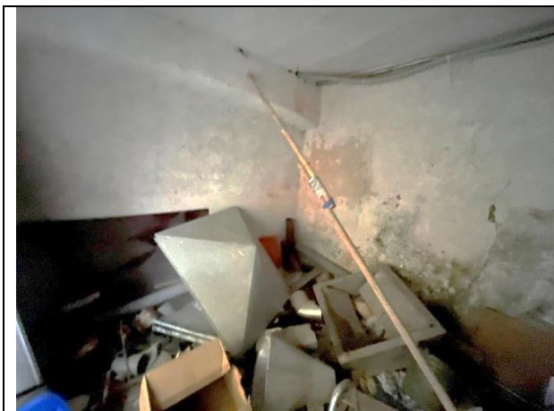
Фото 23. Типичное состояние Объекта оценки
