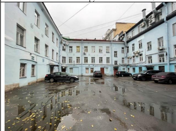
Фото 17. Внутри дворовая территория Объекта оценки
