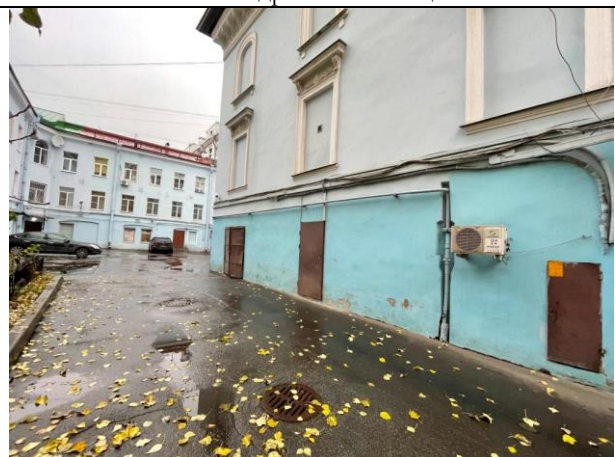
Фото 18. Вид здания расположения Объекта оценки
