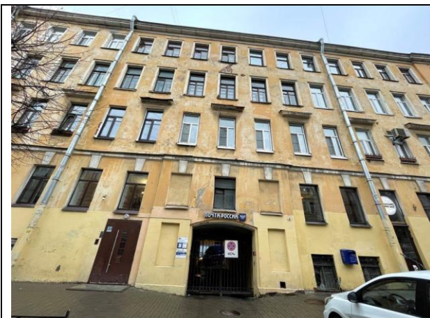
Фото 13. Вид здания расположения Объекта оценки
