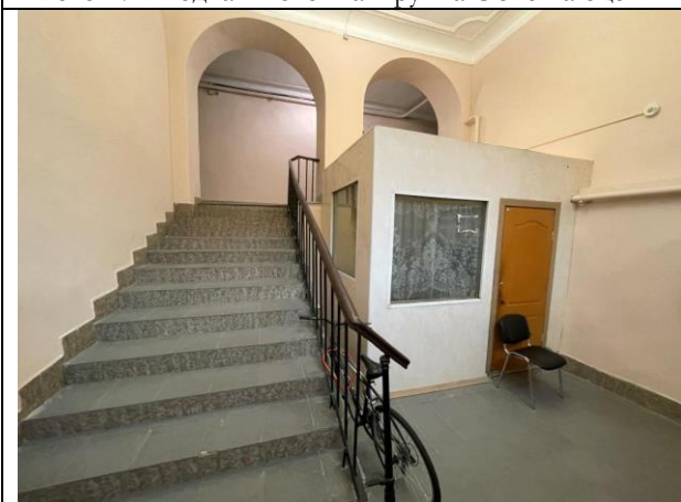
Фото 19. Лестничный проём Объекта оценки
