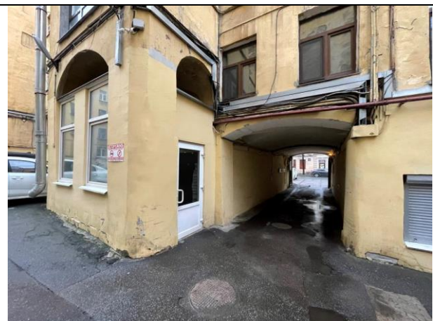
Фото 14. Внутри дворовая территория объекта оценки
