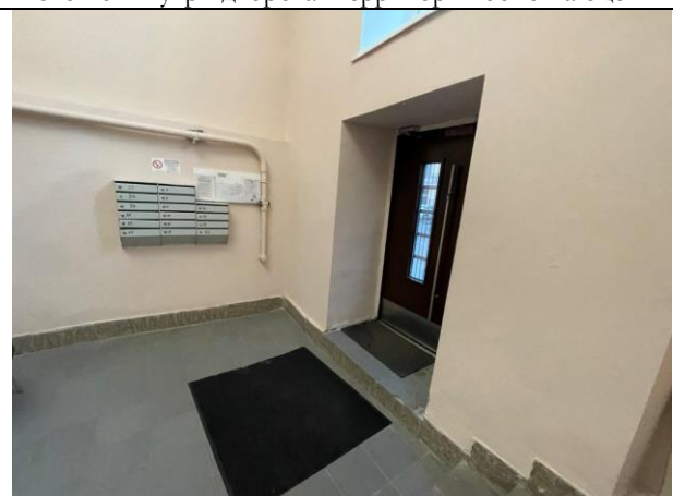
Фото 18. Состояние общей входной группы
