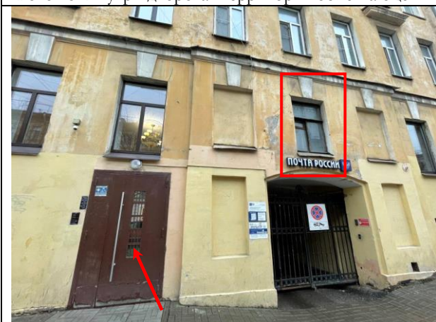
Фото 17. Входная и оконная группа Объекта оценки
