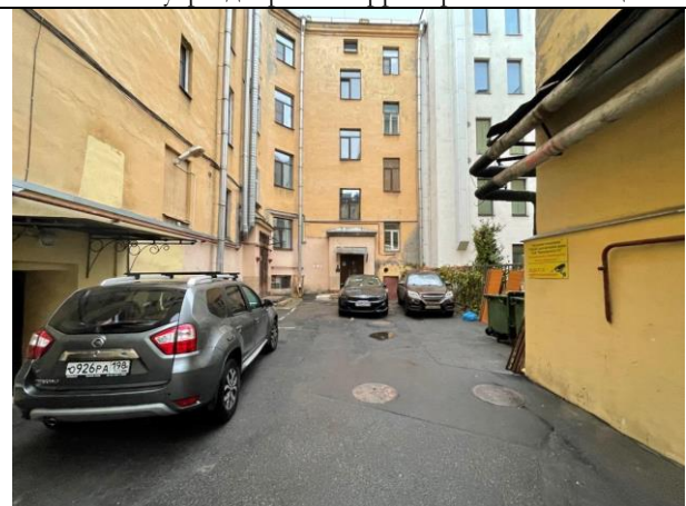
Фото 16. Внутри дворовая территория объекта оценки
