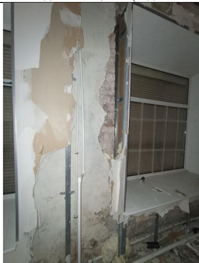
Фото № 9 – Внутреннее состояние помещения
