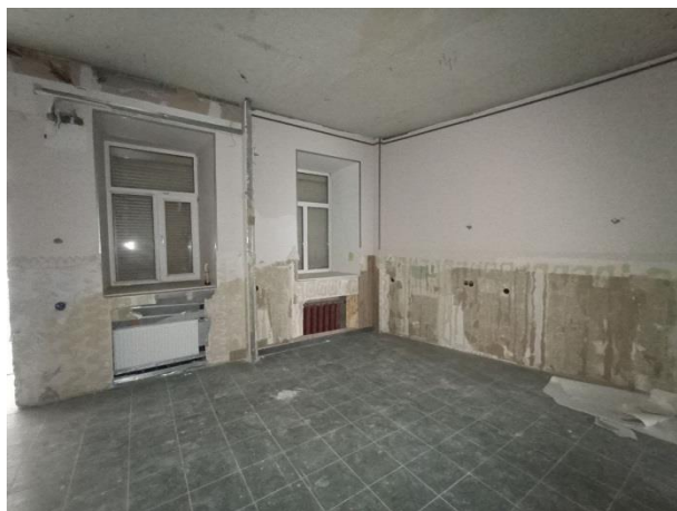
Фото № 13 – Внутреннее состояние помещения
