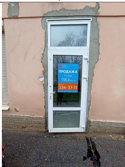
Фото № 7 – Вход в помещение (отдельный с улицы)
