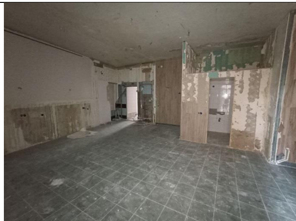
Фото № 12 – Внутреннее состояние помещения
