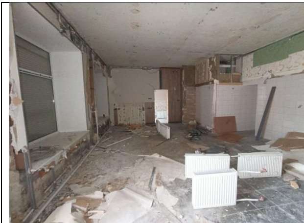
Фото № 11 – Внутреннее состояние помещения
