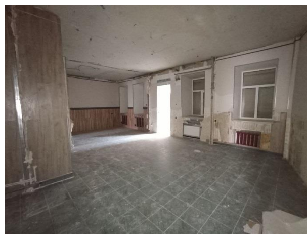
Фото № 8 – Внутреннее состояние помещения
