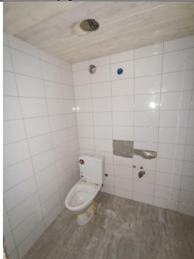
Фото № 14 – Внутреннее состояние помещения
