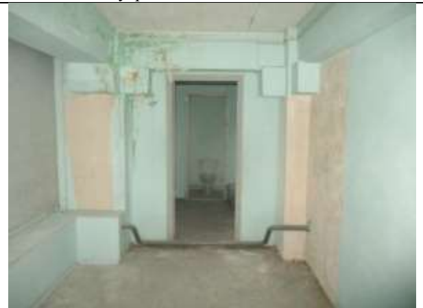
Фото 16. Внутреннее состояние Объекта оценки
