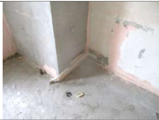
Фото 13. Внутреннее состояние Объекта оценки
