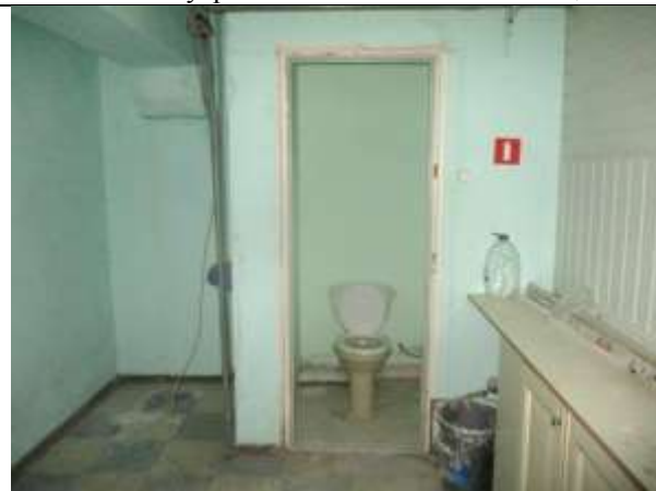
Фото 19. Внутреннее состояние Объекта оценки
