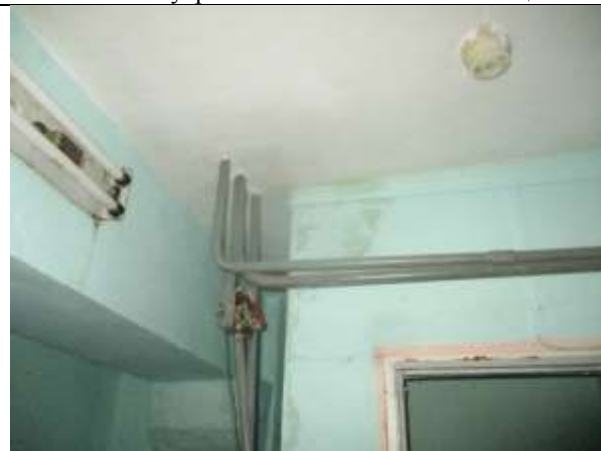
Фото 17. Внутреннее состояние Объекта оценки
