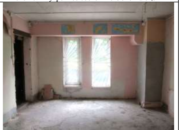
Фото 12. Внутреннее состояние Объекта оценки
