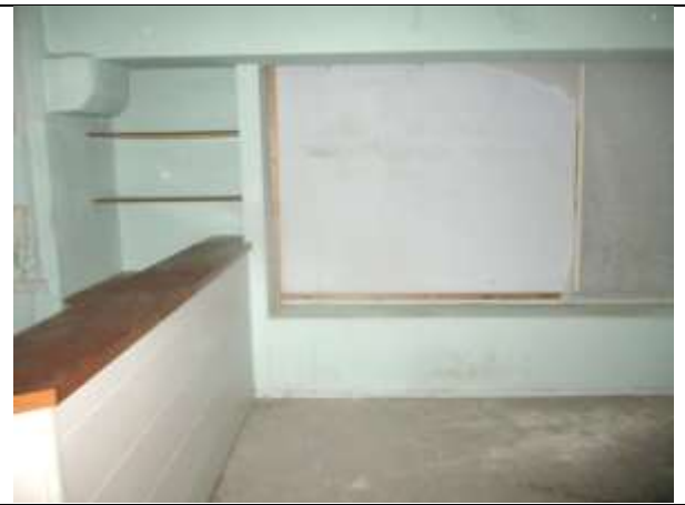
Фото 14. Внутреннее состояние Объекта оценки
