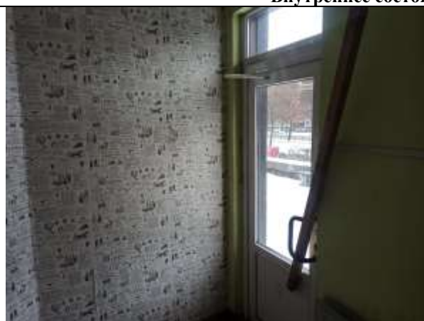
Фото 9. Внутреннее состояние Объекта оценки
