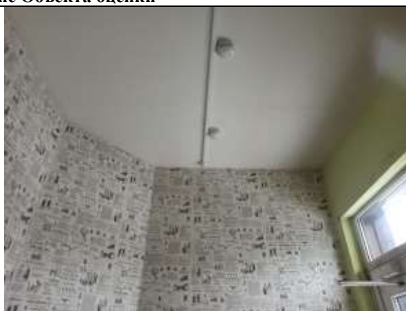
Фото 10. Внутреннее состояние Объекта оценки
