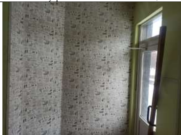
Фото 11. Внутреннее состояние Объекта оценки
