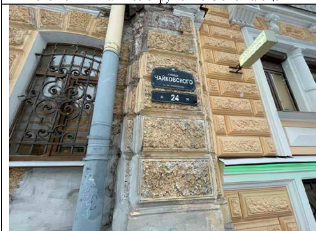
Фото 17. Адрес Объекта оценки
