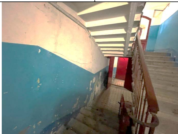
Фото 32. Лестничный проём Объекта оценки
