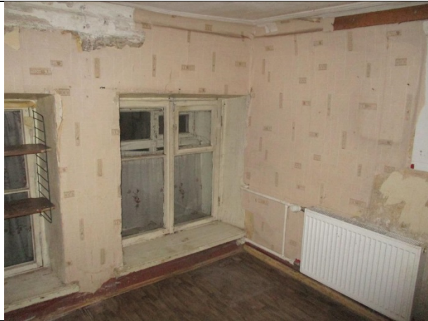
Фото 17 Вид помещения 5-Н
