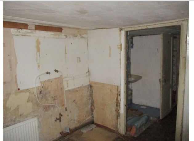
Фото 16 Вид помещения 5-Н
