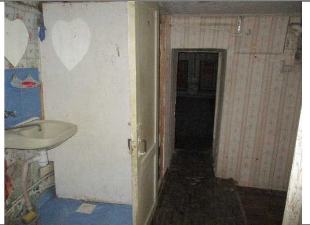
Фото 18 Вид помещения 5-Н
