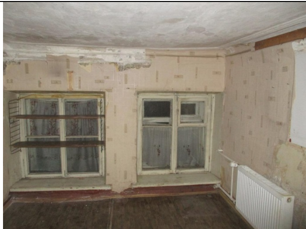
Фото 15 Вид помещения 5-Н
