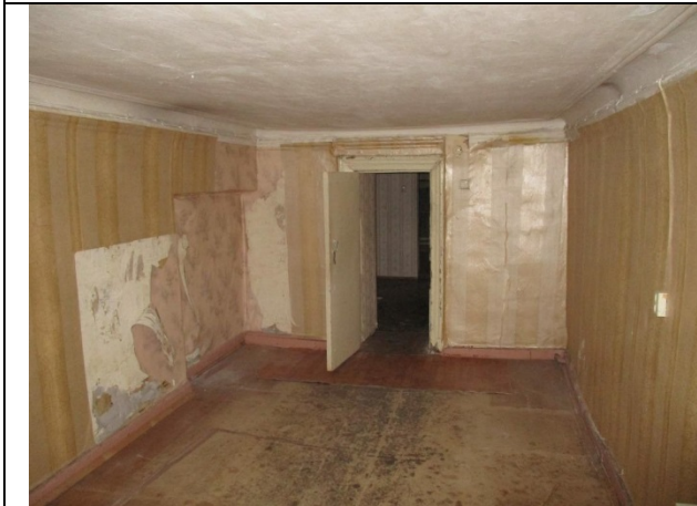
Фото 21 Вид помещения 5-Н
