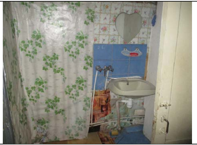
Фото 14 Вид помещения 5-Н
