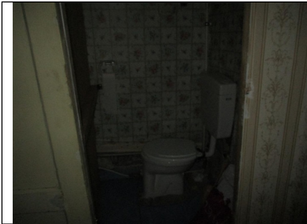
Фото 19 Вид помещения 5-Н
