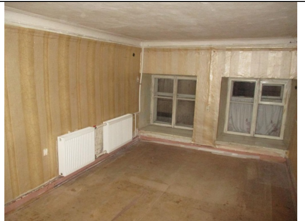
Фото 22 Вид помещения 5-Н
