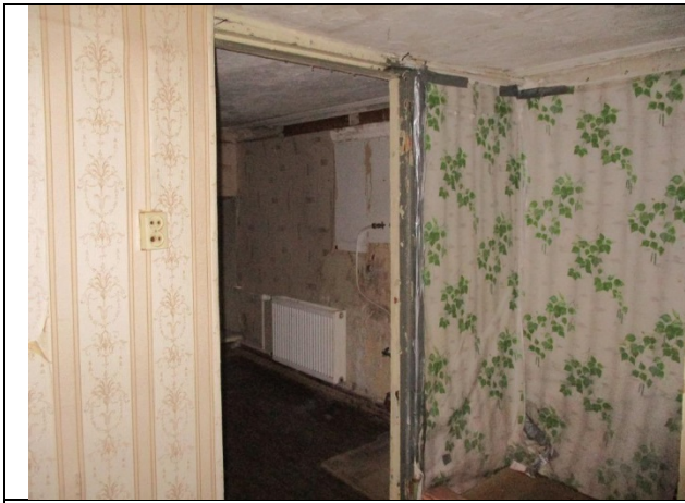
Фото 13 Вид помещения 5-Н
