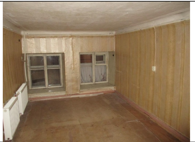
Фото 20 Вид помещения 5-Н
