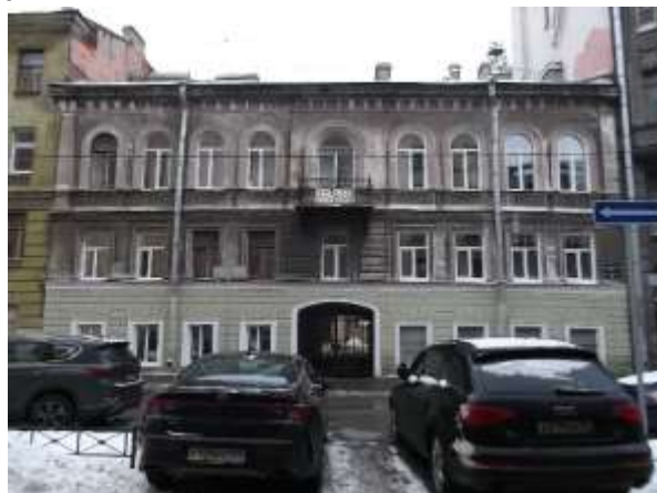
Фото 2. Вид здания, в котором расположен Объект оценки, с улицы Канонерской
