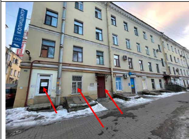
Фото 23. Вид здания расположения Объекта оценки, входная и оконная группа Объекта оценки
