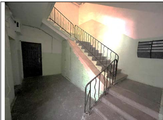
Фото 25. Лестничный пролет Объекта оценки
