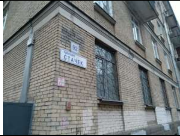
Фото 3. Вид здания, в котором расположен Объект оценки
