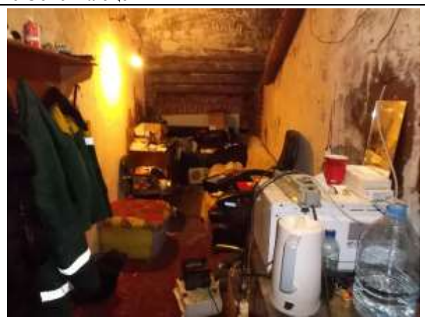
Фото 11. Внутреннее состояние Объекта оценки
