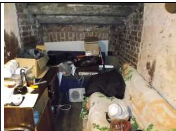
Фото 12. Внутреннее состояние Объекта оценки
