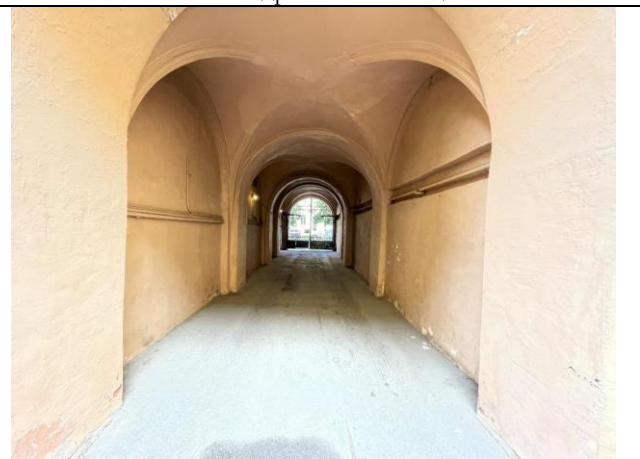
Фото 22. Проход через арку к Объекту оценки
