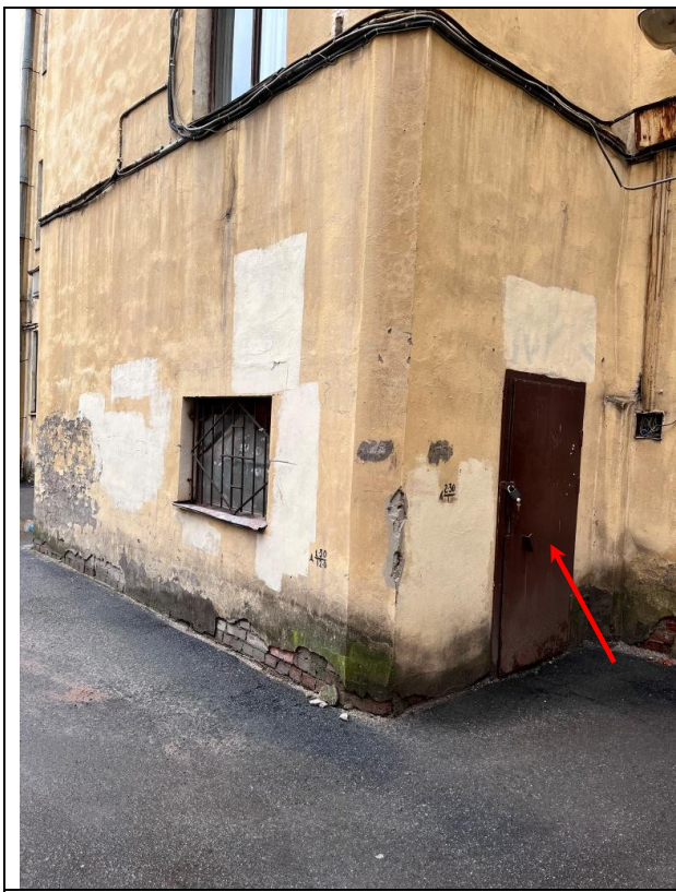
Фото 29. Входная и оконная группа Объекта оценки
