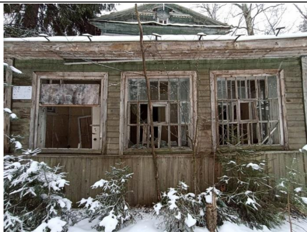
Фото № 9. Внешний вид здания
