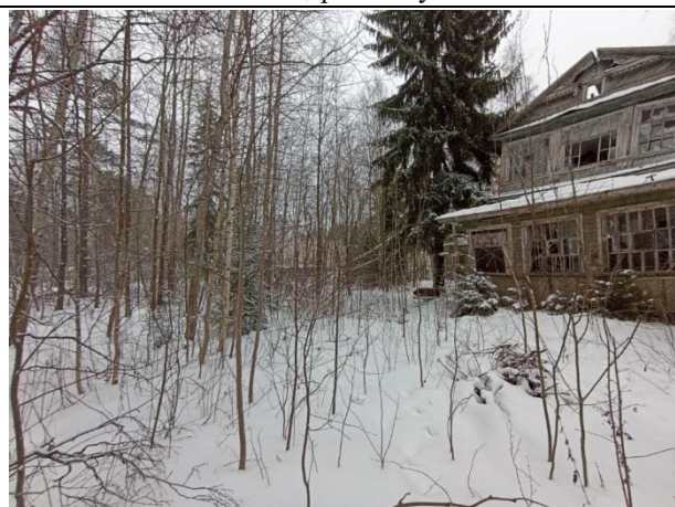
Фото № 7. Внешний вид земельного участка и здания
