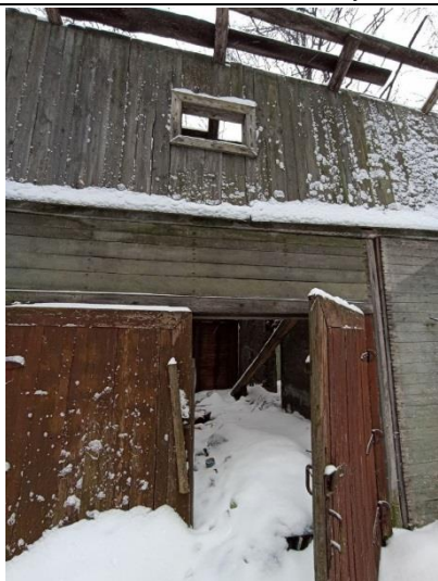
Фото № 13. Внешний вид здания
