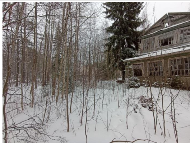
Фото № 7. Внешний вид земельного участка и здания
