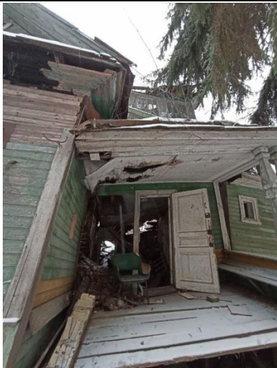
Фото № 11. Внешний вид земельного участка и здания
