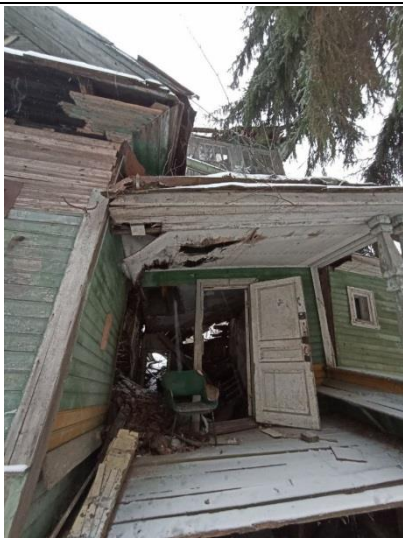
Фото № 11. Внешний вид земельного участка и здания
