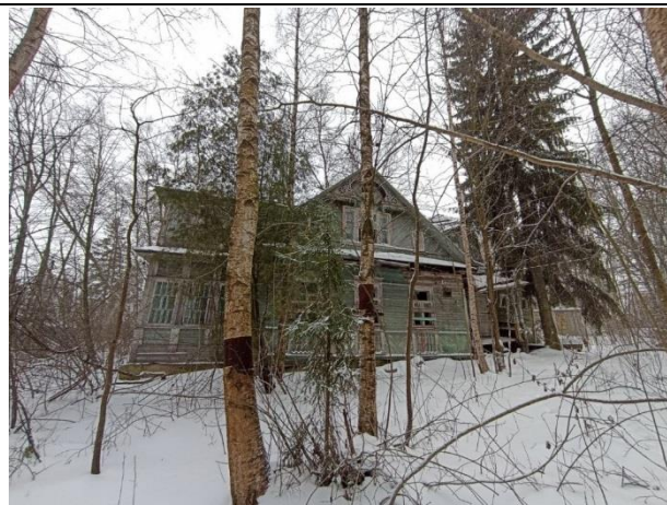
Фото № 10. Внешний вид земельного участка и здания
