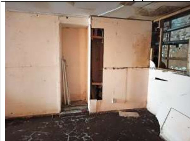
Фото 9. Внутреннее состояние Объекта оценки
