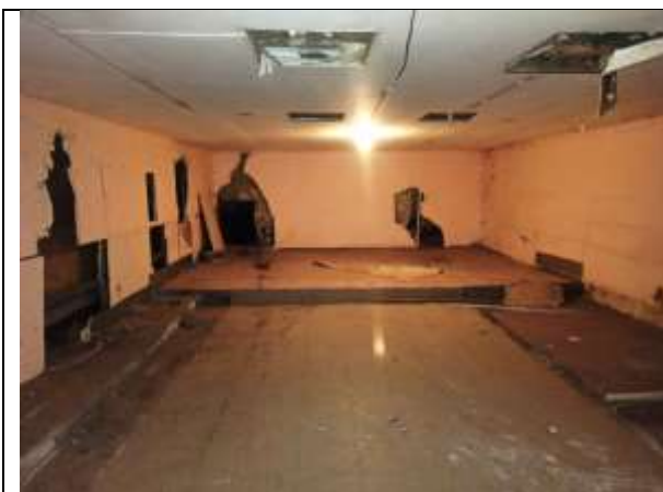
Фото 21. Внутреннее состояние Объекта оценки
