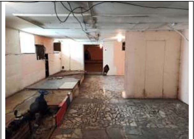
Фото 10. Внутреннее состояние Объекта оценки
