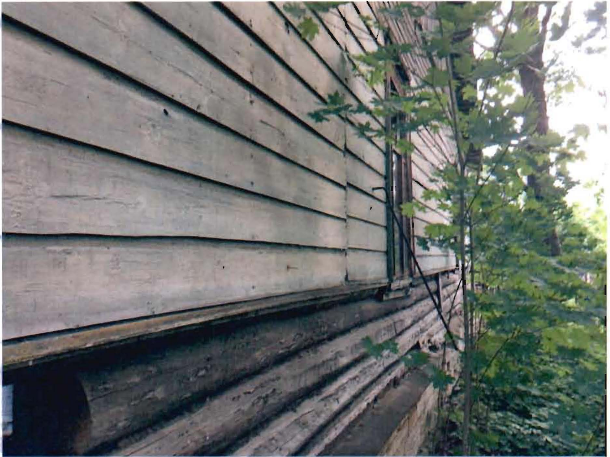
Фото № 3. Часть Восточного фасада
