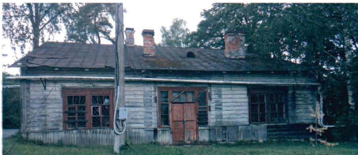
Фото №1. Южный фасад.
