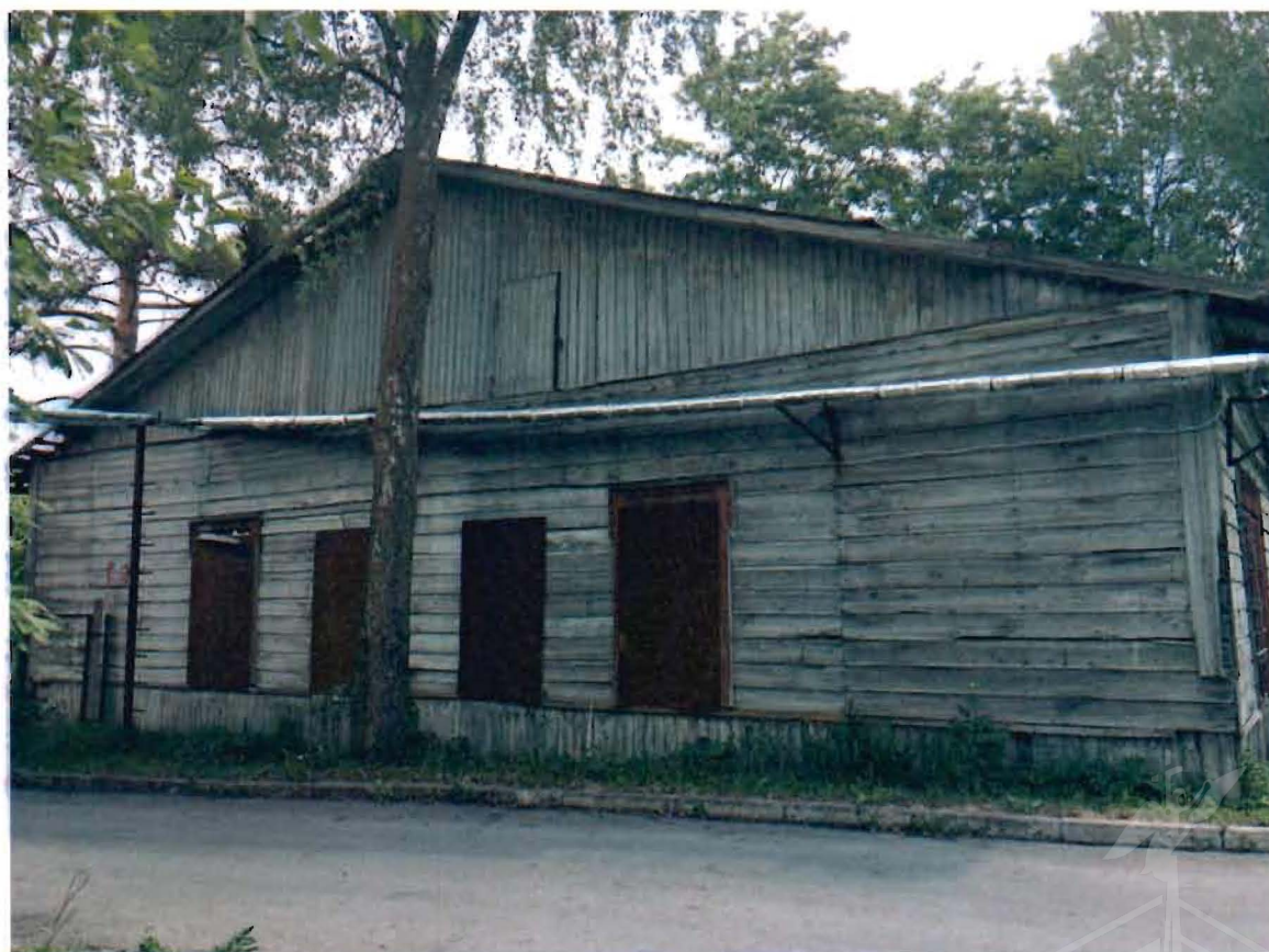
Фото №2. Западный фасад.
