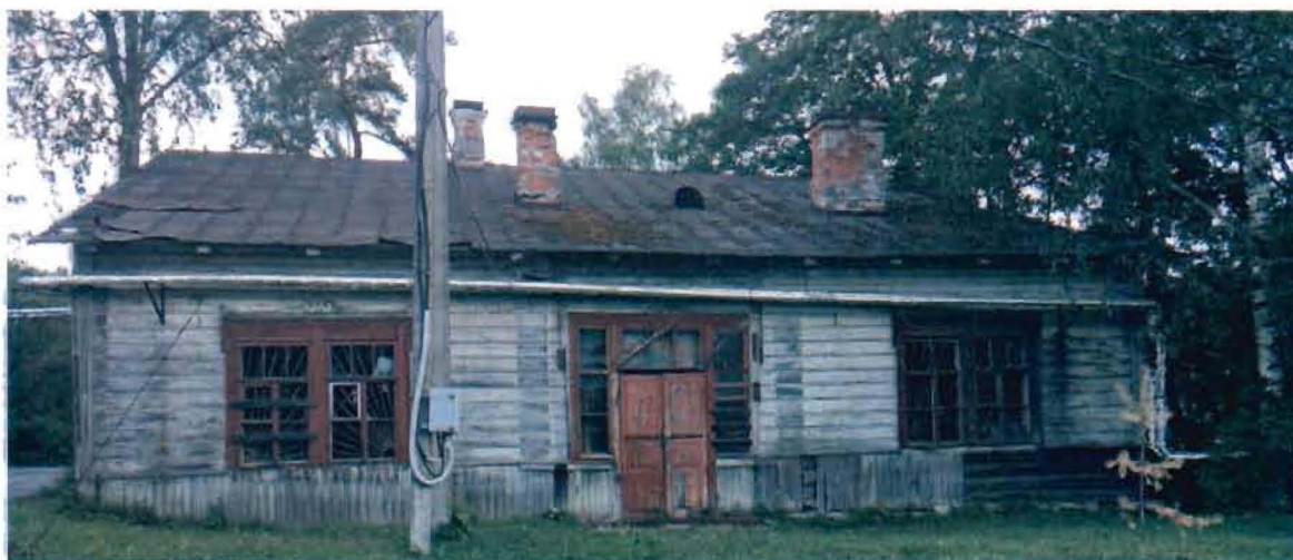
Фото №1. Южный фасад.
