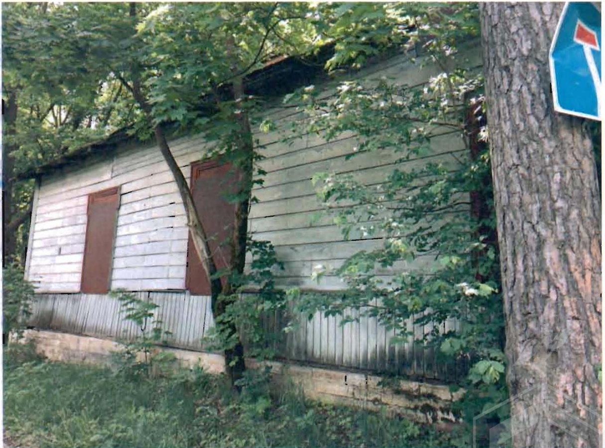
Фото № 4. Северный фасад.
