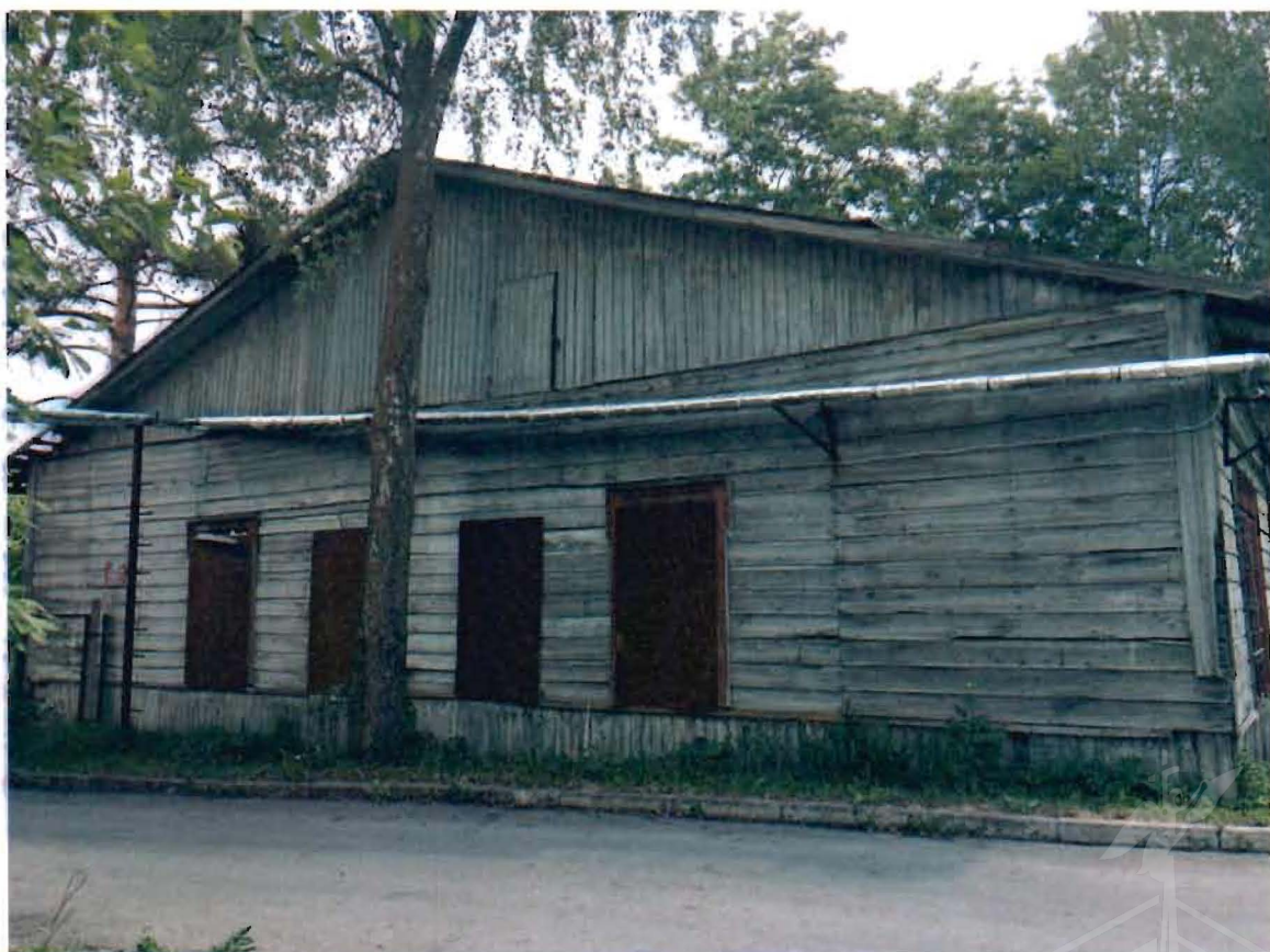
Фото №2. Западный фасад.
