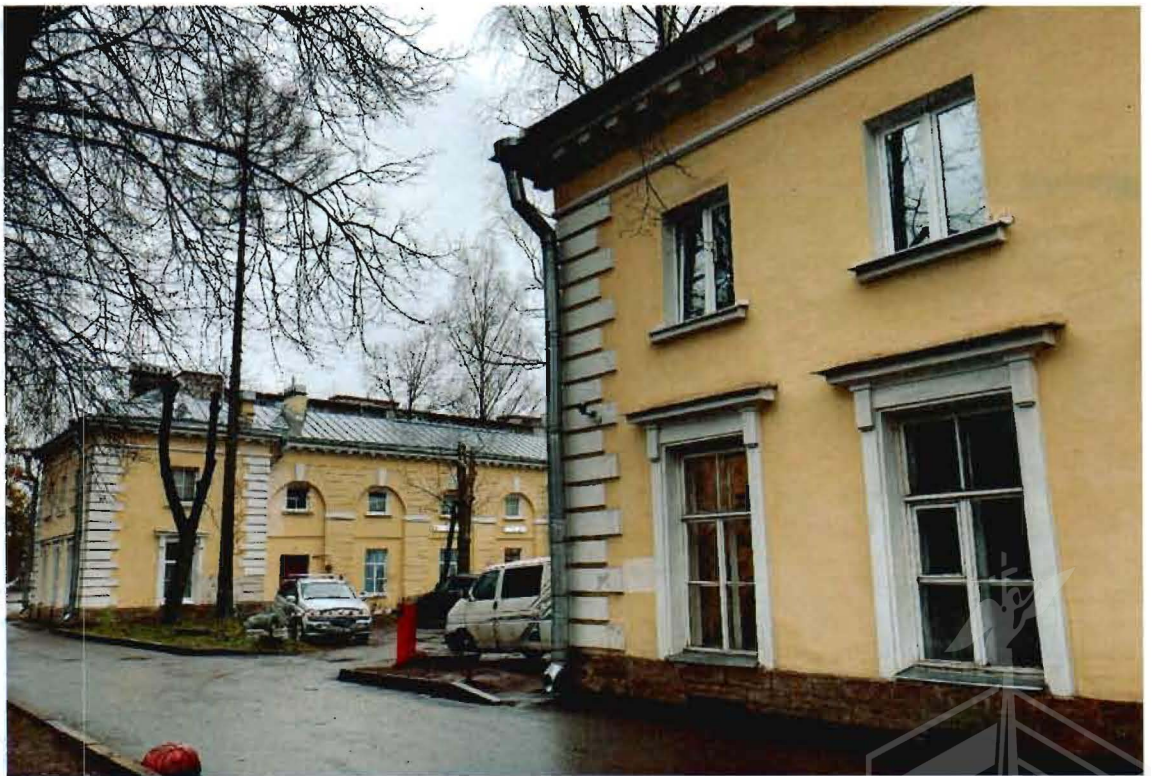
2. Общий вид на объект культурного наследия.
