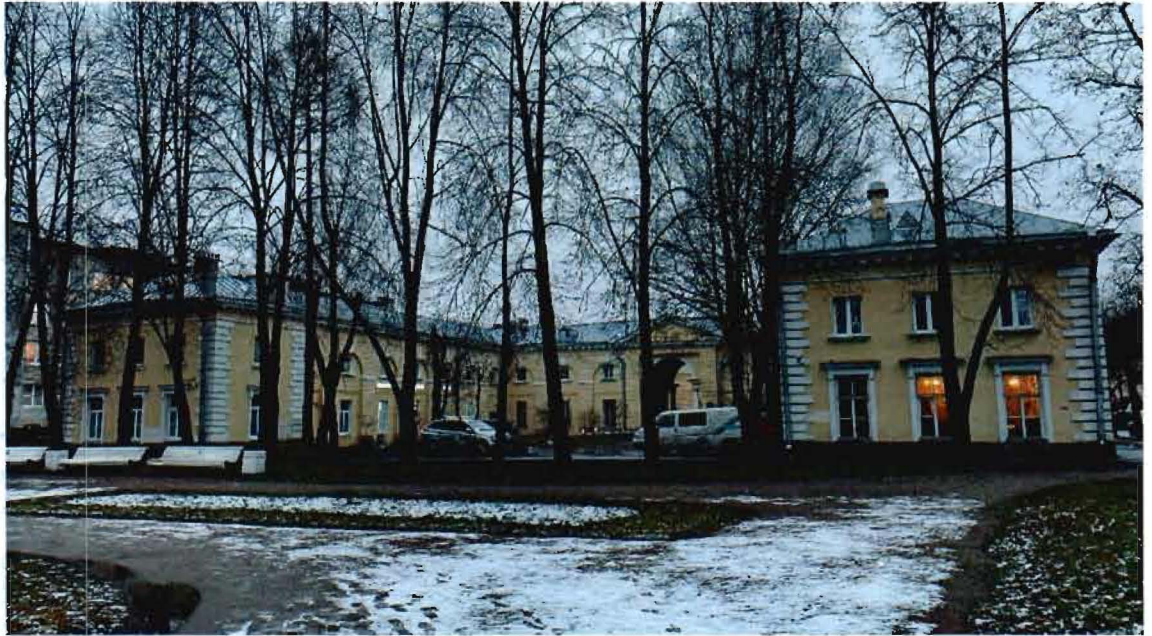
1. Общий вид на объект культурного наследия.
