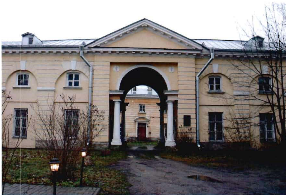
3. Общий вид на объект культурного наследия.
