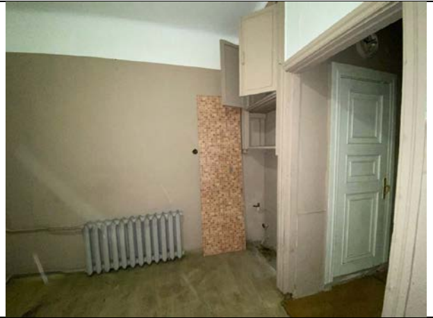
Фото № 14 – Внутреннее состояние помещения
