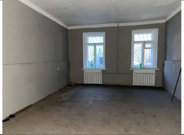
Фото № 16 – Внутреннее состояние помещения
