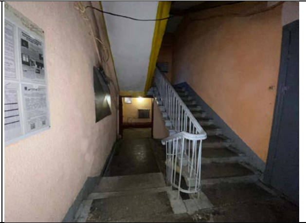
Фото № 8 – Проход к помещению
