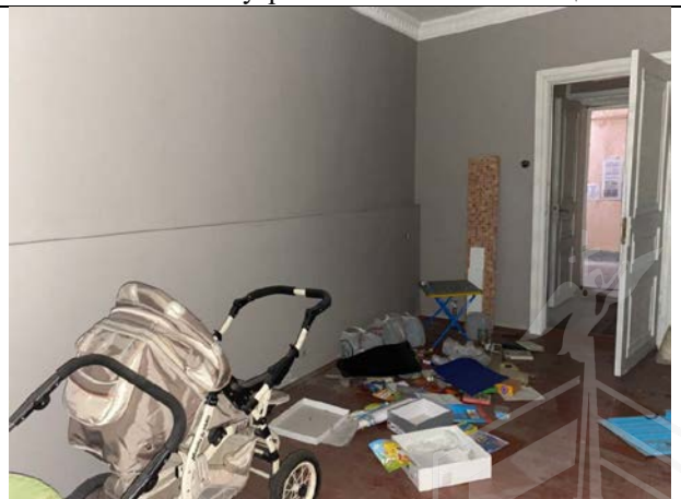
Фото № 20 – Внутреннее состояние помещения
