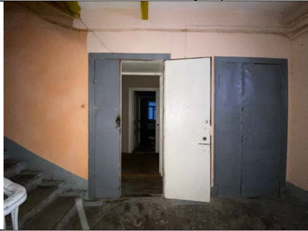
Фото № 9 – Проход к помещению
