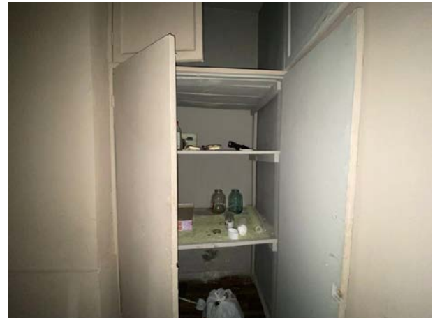
Фото № 12 – Внутреннее состояние помещения
