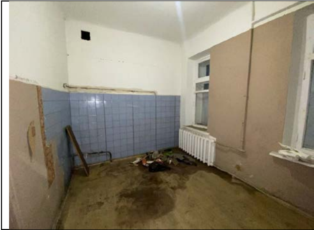
Фото № 13 – Внутреннее состояние помещения
