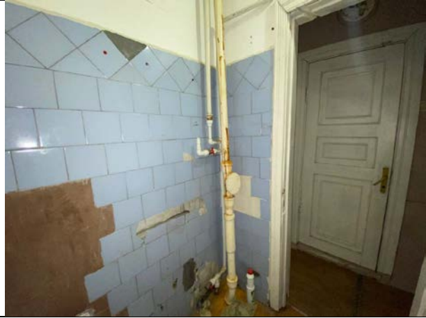
Фото № 15 – Внутреннее состояние помещения
