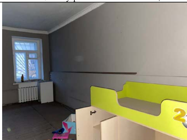
Фото № 17 – Внутреннее состояние помещения
