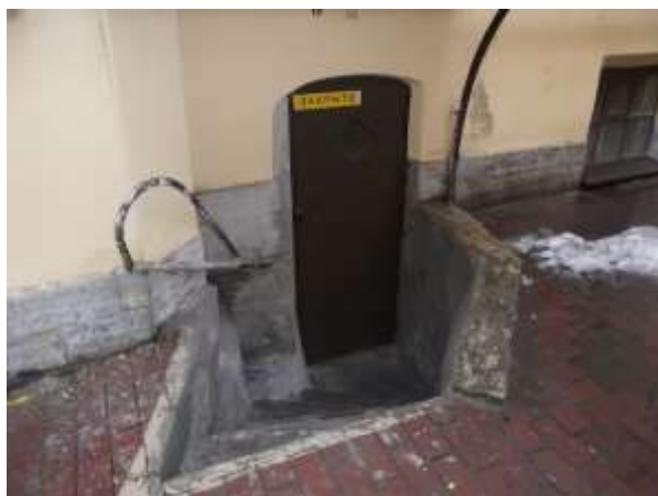
Фото 7. Отдельный вход Объекта оценки
