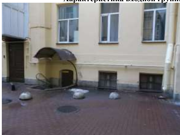
Фото 5. Отдельный вход со двора и окна Объекта оценки
