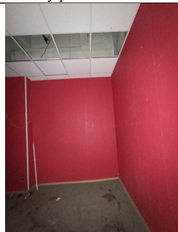
Фото № 38 – Внутреннее состояние помещения
