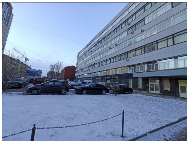
Фото № 2 – Ближайшее окружение и подъездные пути
