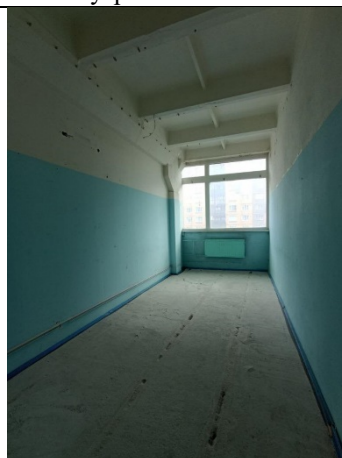
Фото № 22 – Внутреннее состояние помещения
