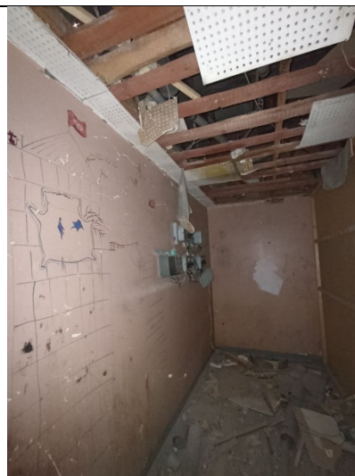
Фото № 20 – Внутреннее состояние помещения
