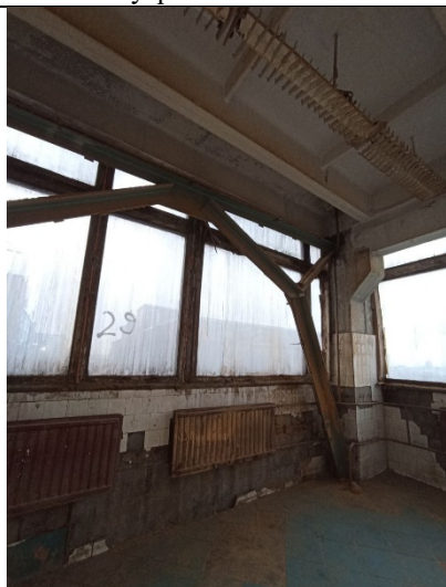
Фото № 23 – Внутреннее состояние помещения
