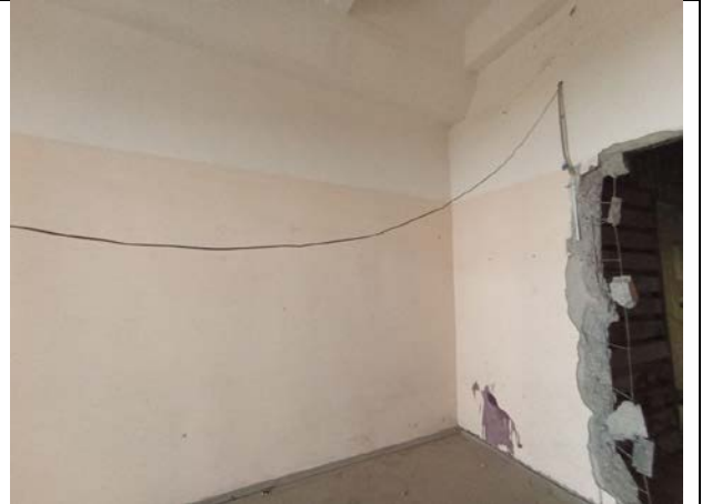
Фото № 28 – Внутреннее состояние помещения
