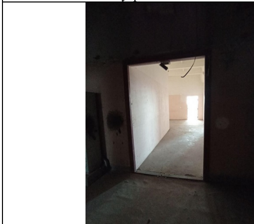
Фото № 9 – Внутреннее состояние помещения
