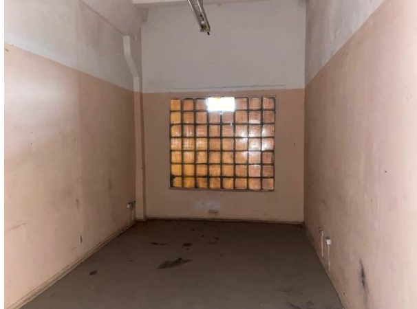
Фото № 13 – Внутреннее состояние помещения
