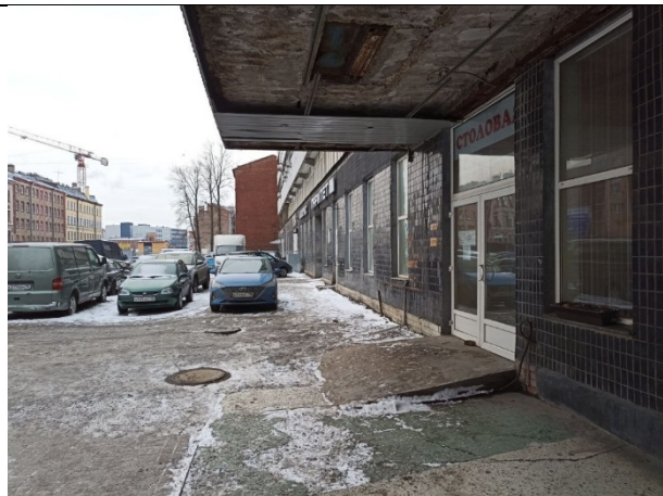
Фото № 4 – Ближайшее окружение и подъездные пути
