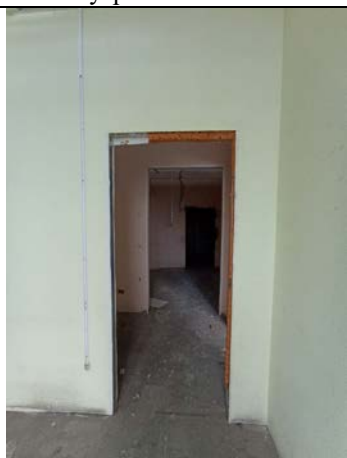
Фото № 21 – Внутреннее состояние помещения
