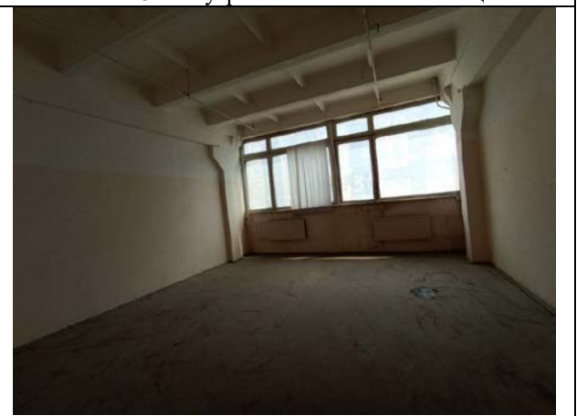
Фото № 30 – Внутреннее состояние помещения
