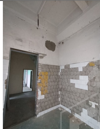
Фото № 40 – Внутреннее состояние помещения
