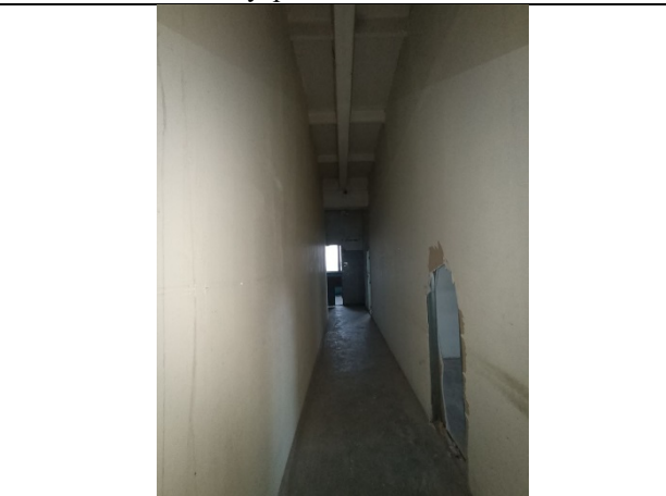
Фото № 16 – Внутреннее состояние помещения
