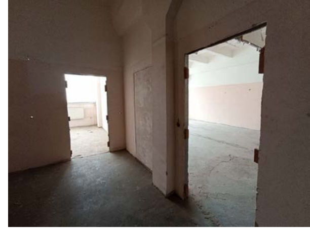
Фото № 14 – Внутреннее состояние помещения
