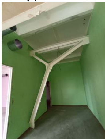
Фото № 37 – Внутреннее состояние помещения
