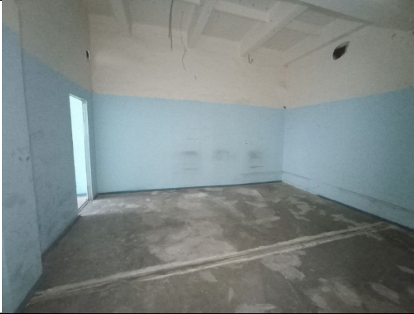
Фото № 25 – Внутреннее состояние помещения
