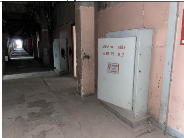
Фото № 15 – Внутреннее состояние помещения
