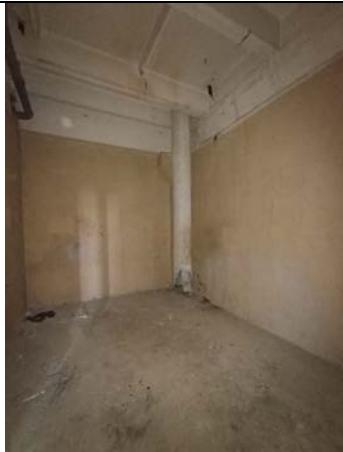
Фото № 39 – Внутреннее состояние помещения
