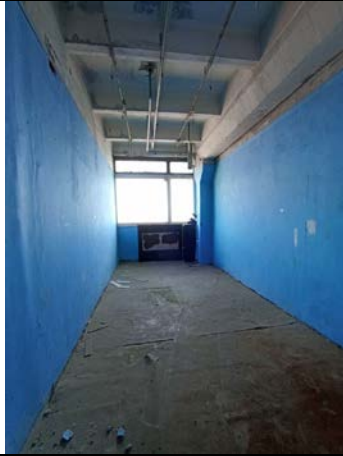
Фото № 33 – Внутреннее состояние помещения
