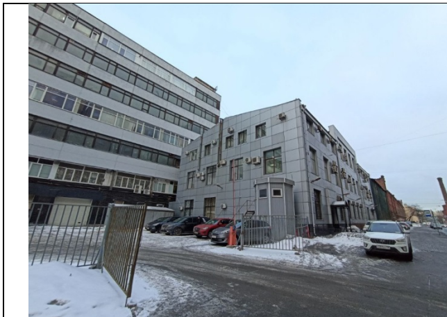
Фото № 3 – Ближайшее окружение и подъездные пути
