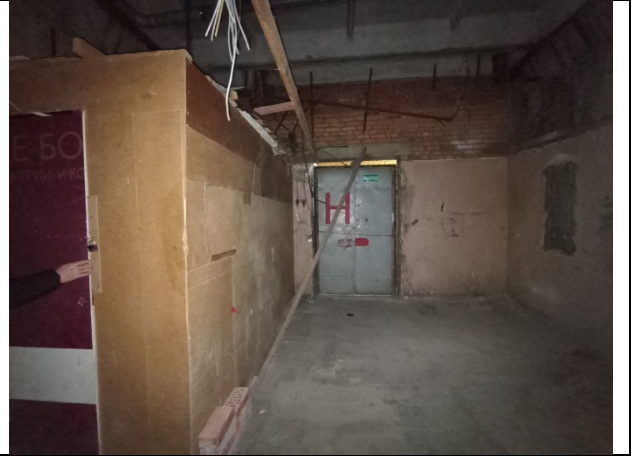
Фото № 34 – Внутреннее состояние помещения
