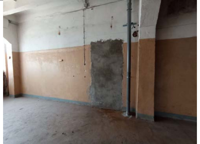
Фото № 36 – Внутреннее состояние помещения
