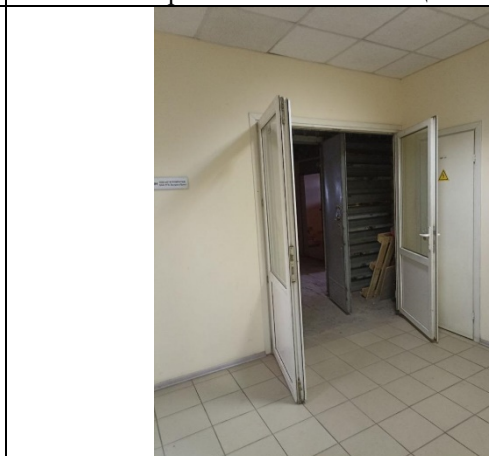
Фото № 8 – Внутреннее состояние помещения
