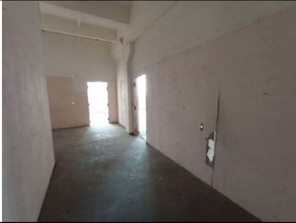
Фото № 11 – Внутреннее состояние помещения
