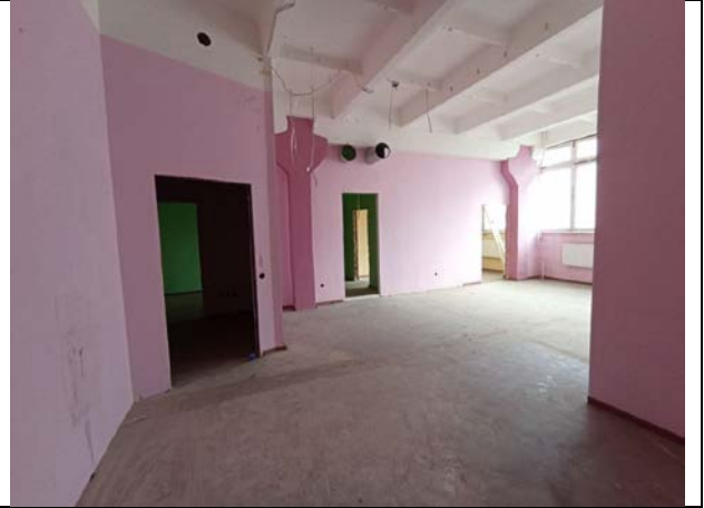
Фото № 26 – Внутреннее состояние помещения
