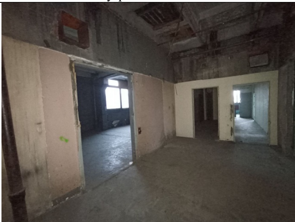
Фото № 31 – Внутреннее состояние помещения
