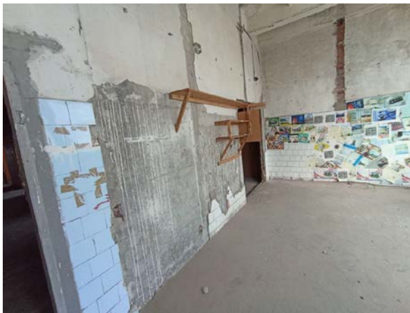
Фото № 35 – Внутреннее состояние помещения
