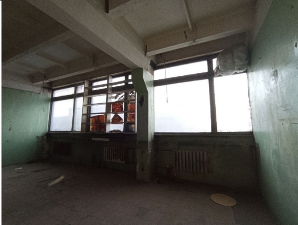
Фото № 27 – Внутреннее состояние помещения
