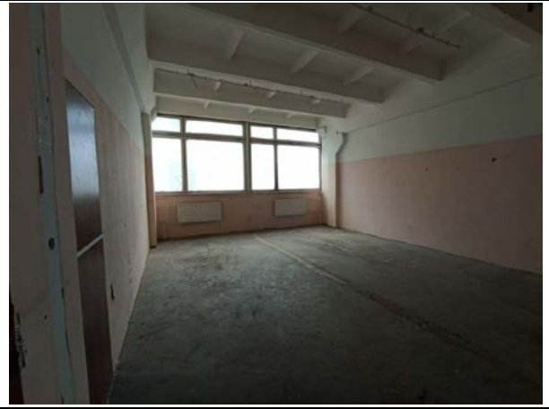
Фото № 12 – Внутреннее состояние помещения
