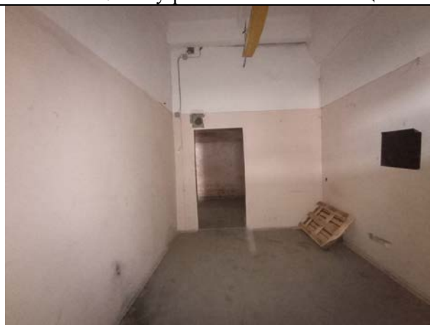
Фото № 29 – Внутреннее состояние помещения
