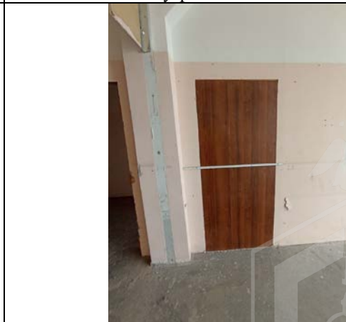
Фото № 10 – Внутреннее состояние помещения
