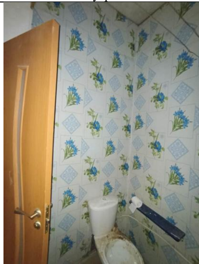
Фото № 16 – Внутреннее состояние
