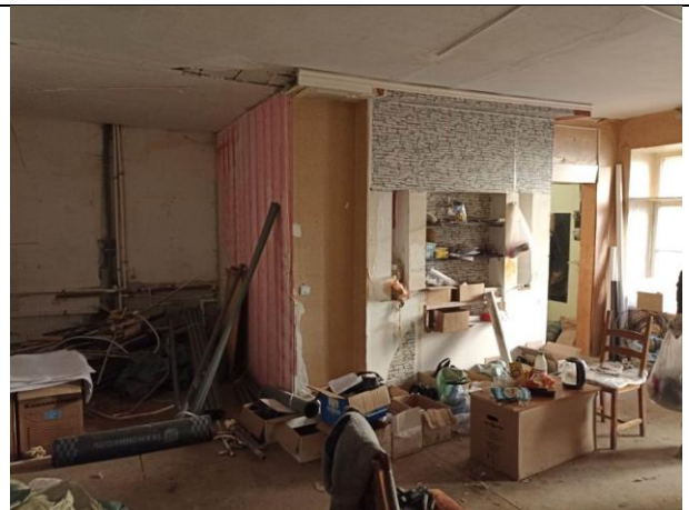
Фото № 8 – Внутреннее состояние
