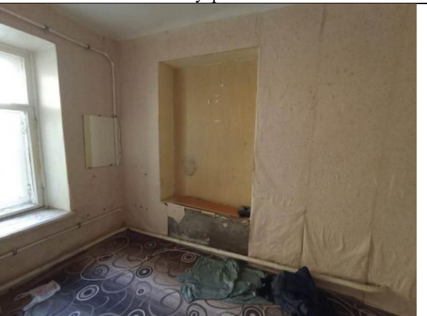
Фото № 10 – Внутреннее состояние
