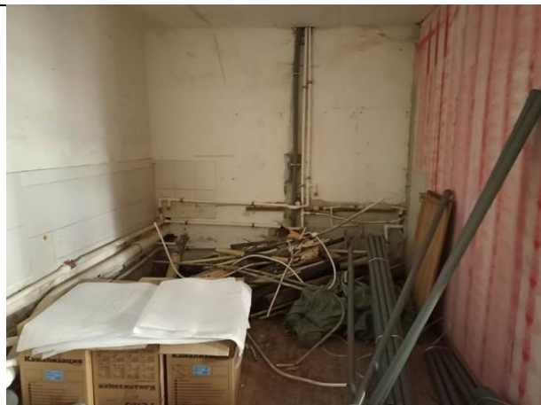
Фото № 6 – Внутреннее состояние
