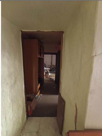
Фото № 13 – Внутреннее состояние
