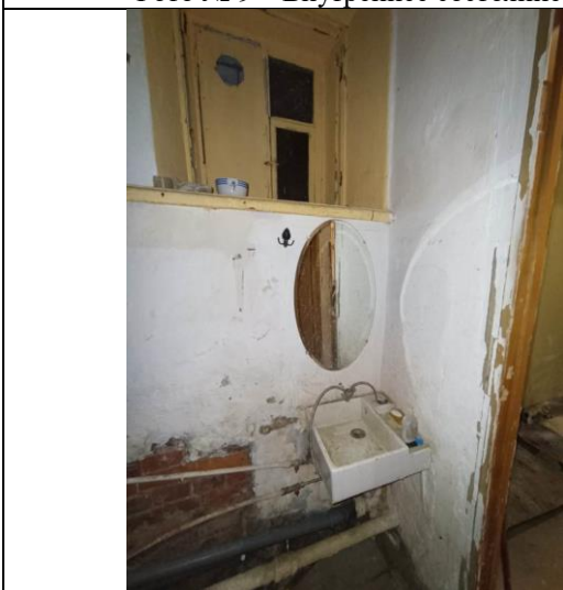
Фото № 11 – Внутреннее состояние
