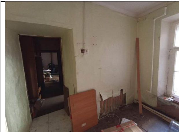
Фото № 7 – Внутреннее состояние
