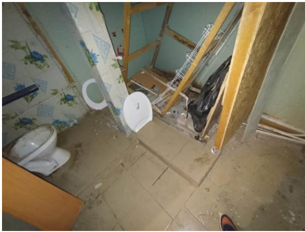
Фото № 15 – Внутреннее состояние
