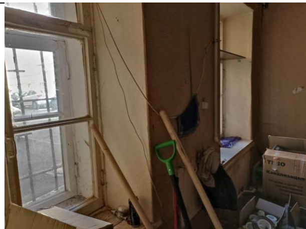
Фото № 5 – Внутреннее состояние
